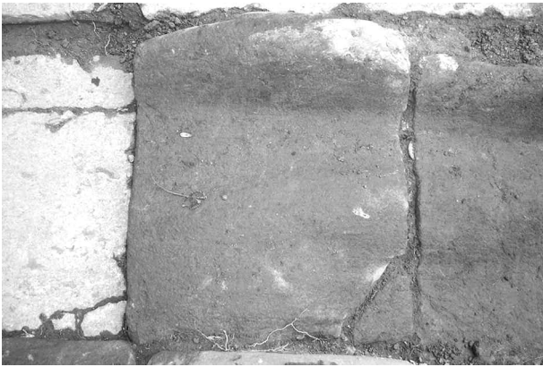
FIG. 23. — Traces d'ornières au passage de l'entrée de la fortification. Cliché R. Clotuche.
