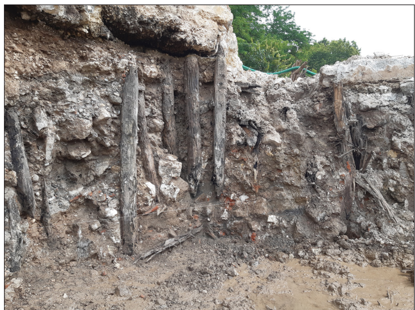
Fig. 1 - Le développement de l'archéologie préventive en milieu humide, fluvial ici, nécessite une attention particulière aux données bioarchéologiques. Fouille Inrap, sous la responsabilité de Marie-Christine Gineste, moulin de Clairac (47). Destruction du moulin (médiéval) pour le rétablissement de la continuité écologique des cours d'eau. (Cliché Ewen Ihuel (DRAC Nouvelle-Aquitaine, SRA))
