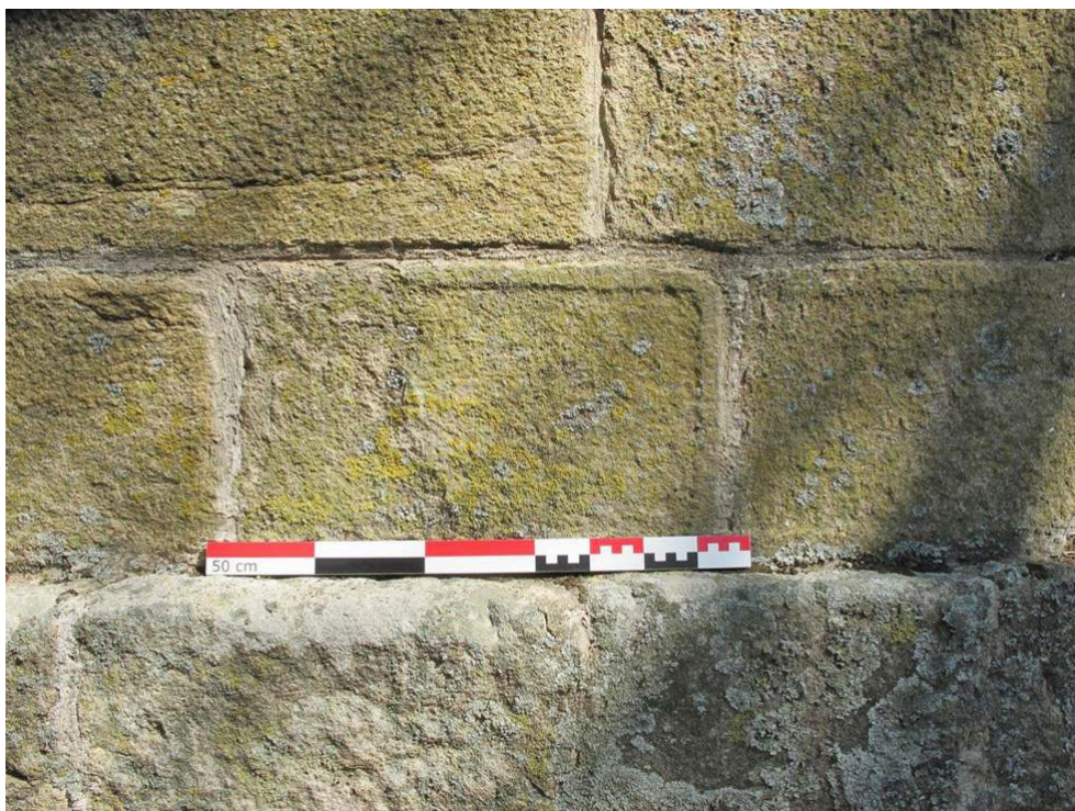
Fig. 6 – Détail du matériau employé pour la construction de l'église Saint-Jean-Baptiste (cl. P. Ferreira).
