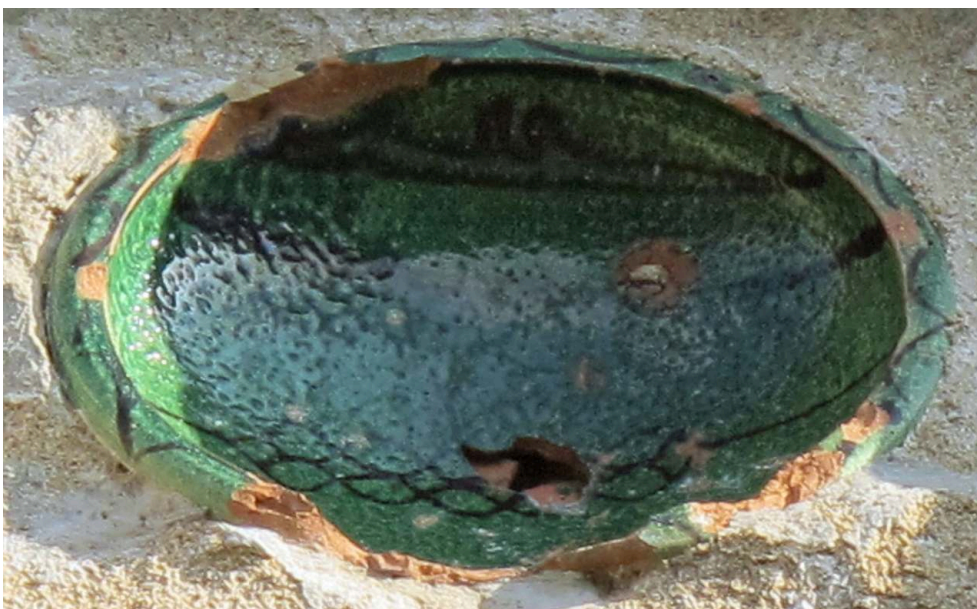
Fig. 3 – Bacini encore en place sur l'une des arcatures du mur gouttereau sud de l'église Saint-Jean-Baptiste (cl. P. Ferreira).
