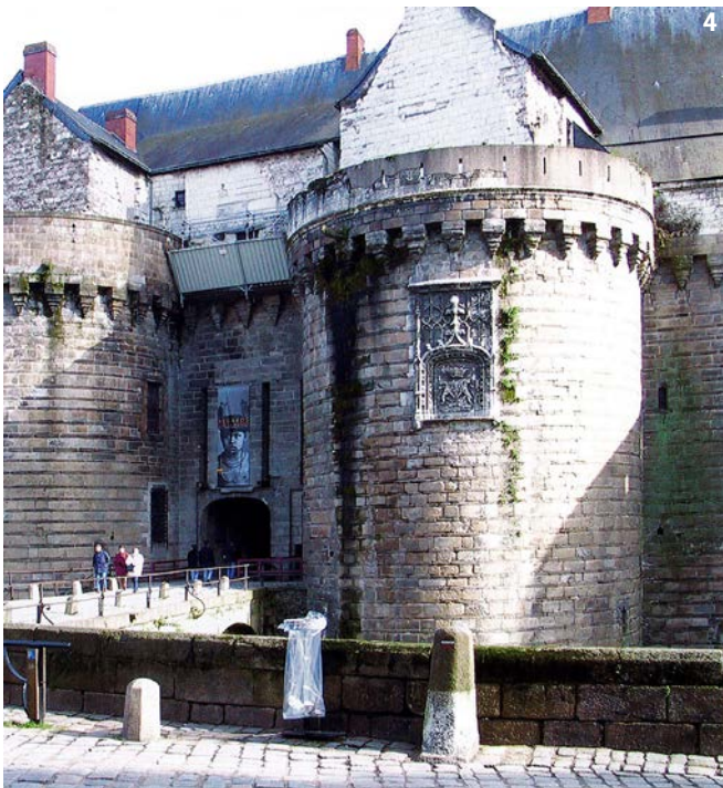
Fig. 5 - Nantes, château des Ducs de Bretagne, le Grand Gouvernement avant restauration, détail, travée nord. (J. Pascal, Inrap)
