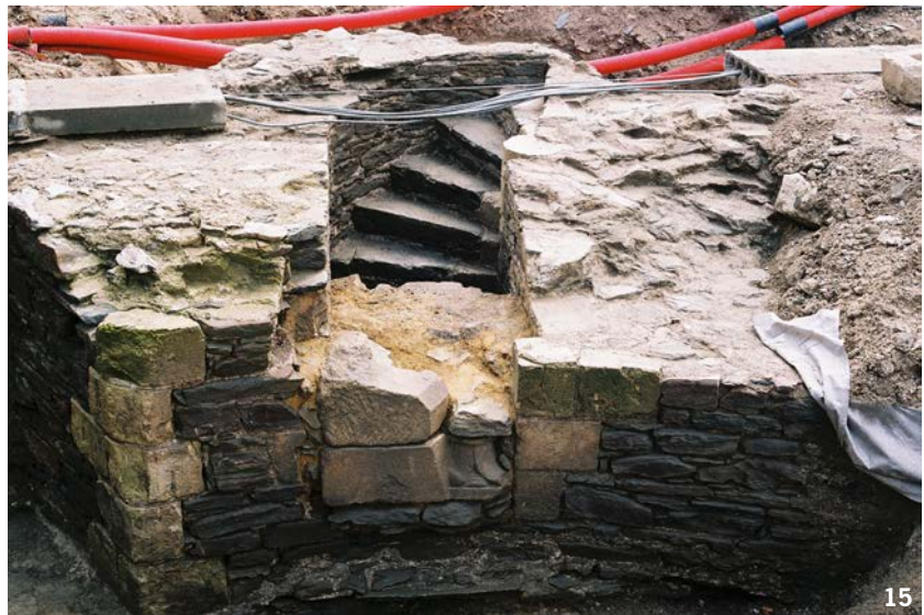
Fig. 15 - Nantes, château des Ducs de Bretagne, cour, tour philippienne du Château de la Tour Neuve, détail de l'escalier à vis. (J. Pascal, Inrap)
