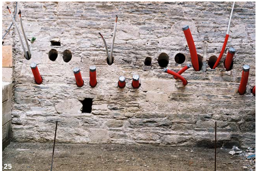
Fig. 25 - Nantes, château des Ducs de Bretagne, passage des réseaux à travers le pignon sud du Grand Logis. (J. Pascal, Inrap)
