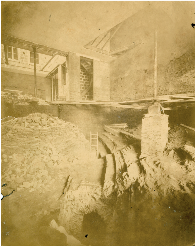
Fig. 1. Anonyme, Toulouse : vue du théâtre antique fouillé par Jacques-Jean Esquié, 1869-1871. Tirage papier, 25x19,5 cm. © Musée Paul-Dupuy, CEE_008_4_92. Fouilles sous la maison Jèze, à l'actuel n° 1 rue de Metz à Toulouse. En bas à droite, on voit les fondations des gradins du théâtre, sous lesquelles courait un égout.
