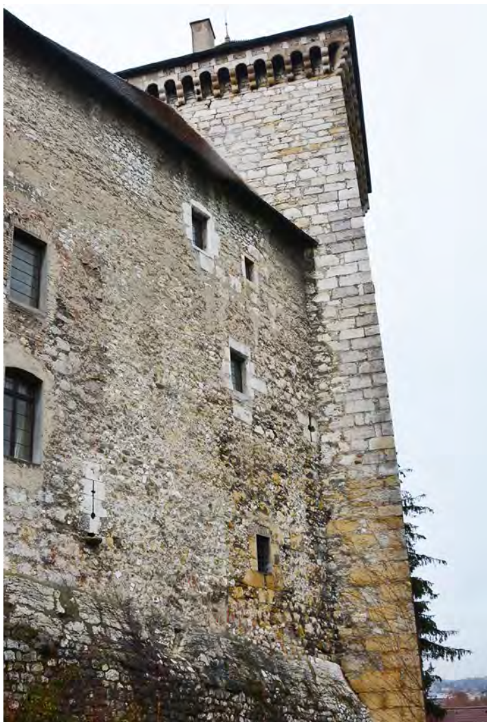
Fig. 27 : Château d'Annecy. Tour et Logis Perrière (ES 6 et 7), canonnières sur la façade sud. Doc. : L. D'Agostino.
