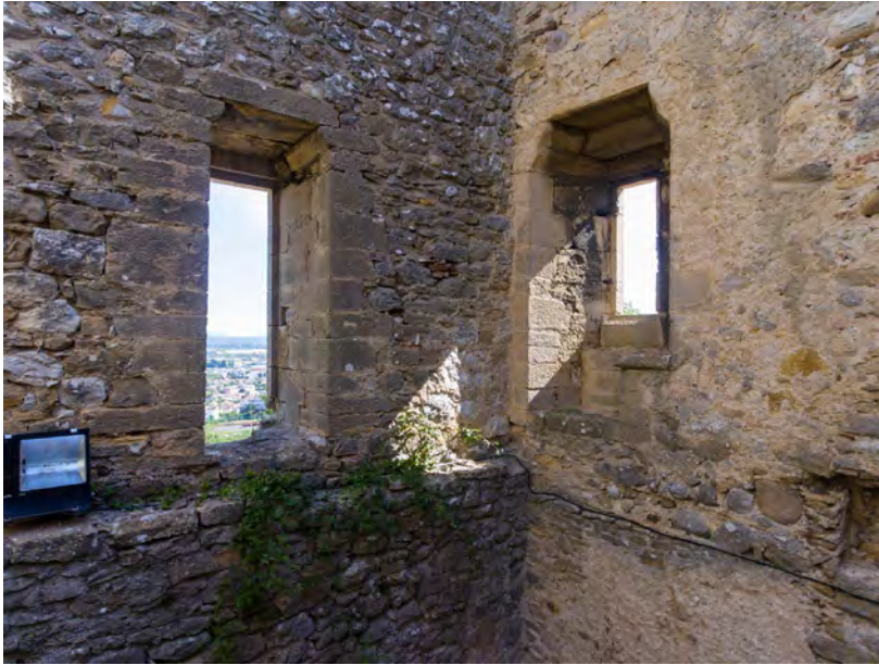
Fig. 25 : Tour de Saint-Denis. 1er étage, porte et jour à coussiège des murs est et nord. Cliché : J. Laidebeur.
