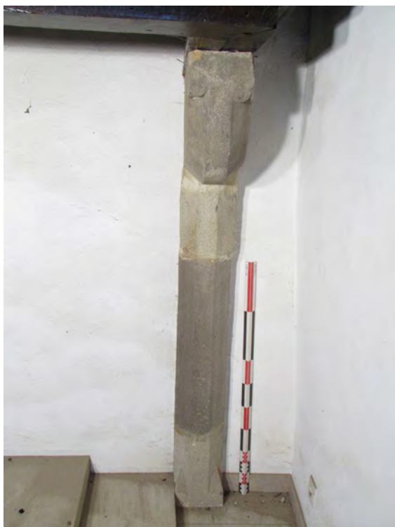
Fig. 18 : Château de Buffavent (Lully, 74). Cheminée de l'étage CH2050, détail du jambage nord-ouest. Cliché : M. Caillet, Hadès
