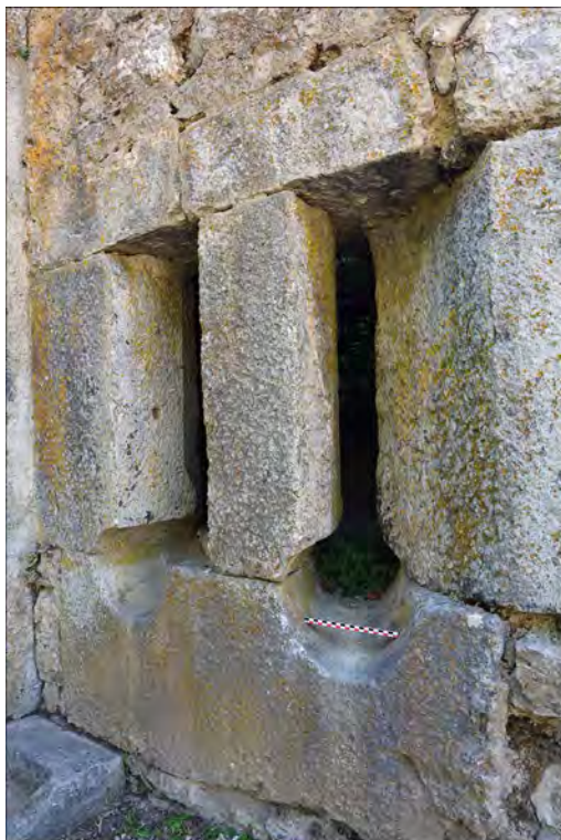
Canonnière double retailée pour être élargie et permettre le tir au mousquet.
