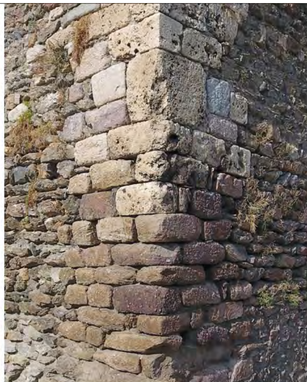
Chaîne d'angle de la tour Sarrasine en granite rouge pour la partie basse.
