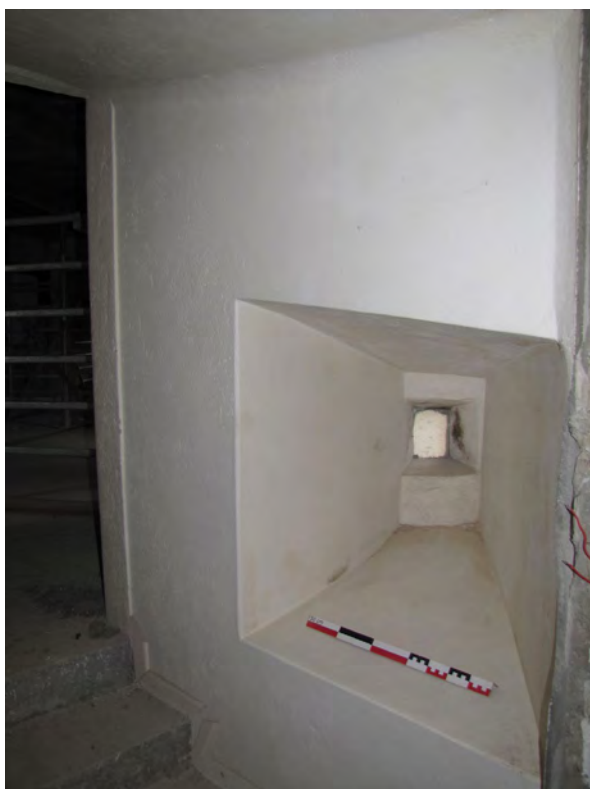
Fig. 42 : Château de Buffavent (Lully, 74). Canonnière de type 2 BE3044 (tour nord, 1er étage), depuis l'intérieur. Cliché : M. Caillet
