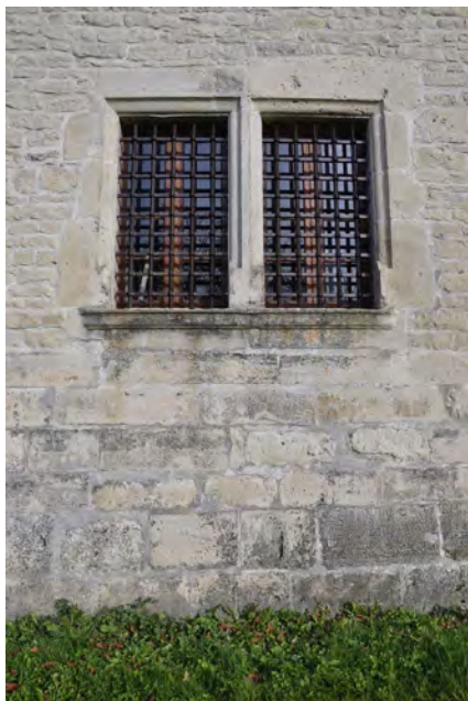
Fig. 16 : Château de Regard, Clermont (74). Baie double à doucines du rez-de-chaussée du pavillon sud-ouest. Cliché : L. D'Agostino.
