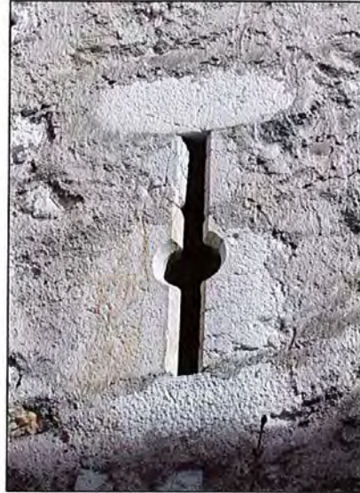
Archère-canonnière à trou central située sur le parement Ouest de la tour Sud (1 er étage).
