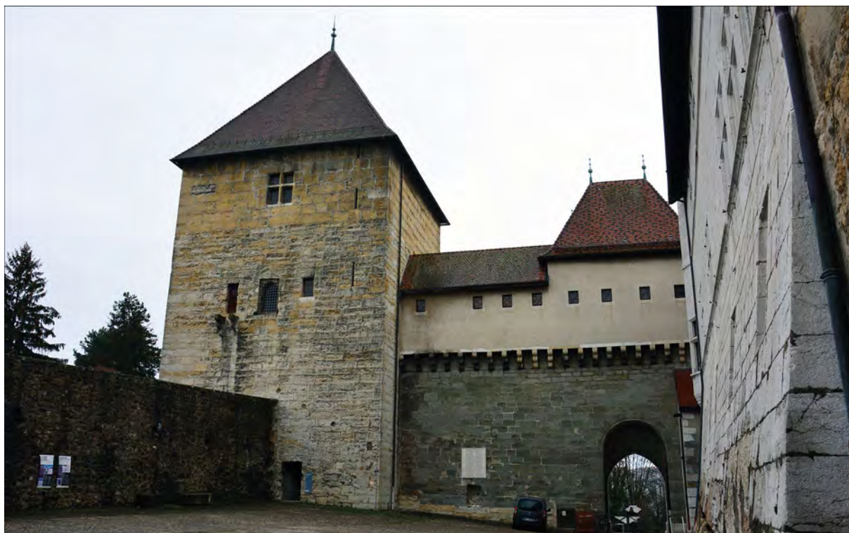
La Tour de la Reine et la courtine occidentale vues depuis la cour du château, à l'est. Cliché : E. Chauvin-Desfleurs.
