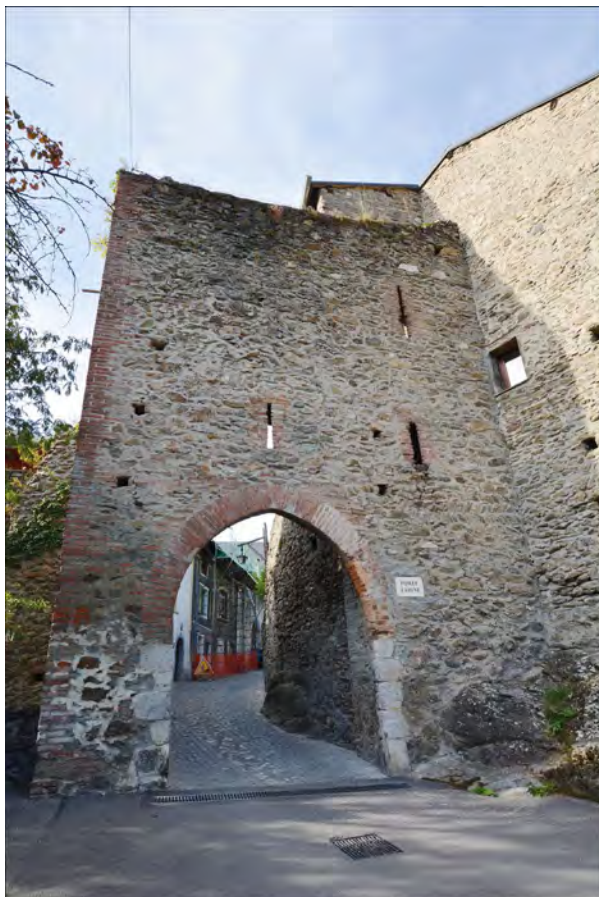
Façade principale de la tour porte.
