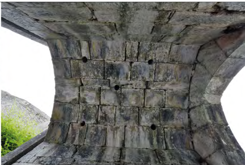
Cinq canonnières aménagées dans la voûte de la deuxième porte.
