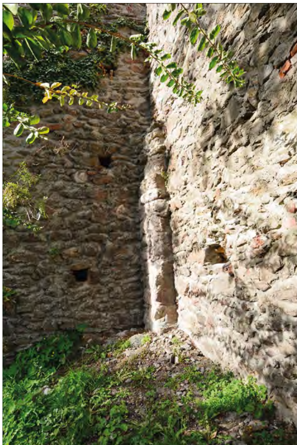
Mur latéral de la tour porte qui vient s'appuyer sur un chaînage en granite rouge.
