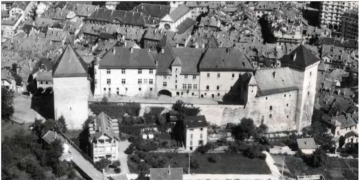
Vue aérienne du château d'Annecy vu du sud en 1952. Cliché : Combier.
