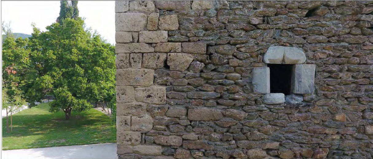
Vue générale de la fenêtre FEN 12 du mur sud M 4.
