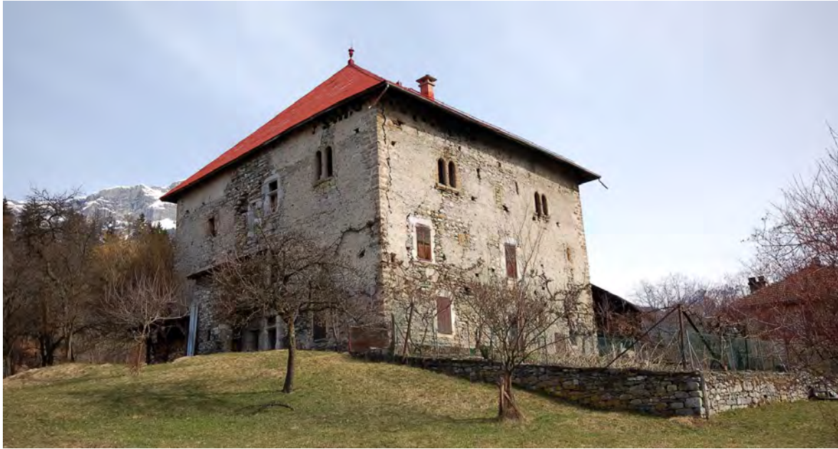
Fig. 4 : Maison forte de Dingy (Passy, Haute-Savoie).
