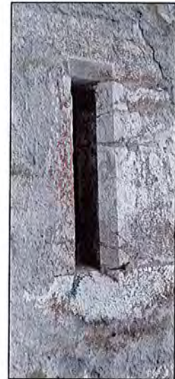
Archère simple située sur le parement Est de la tour Nord (2 ème étage).
