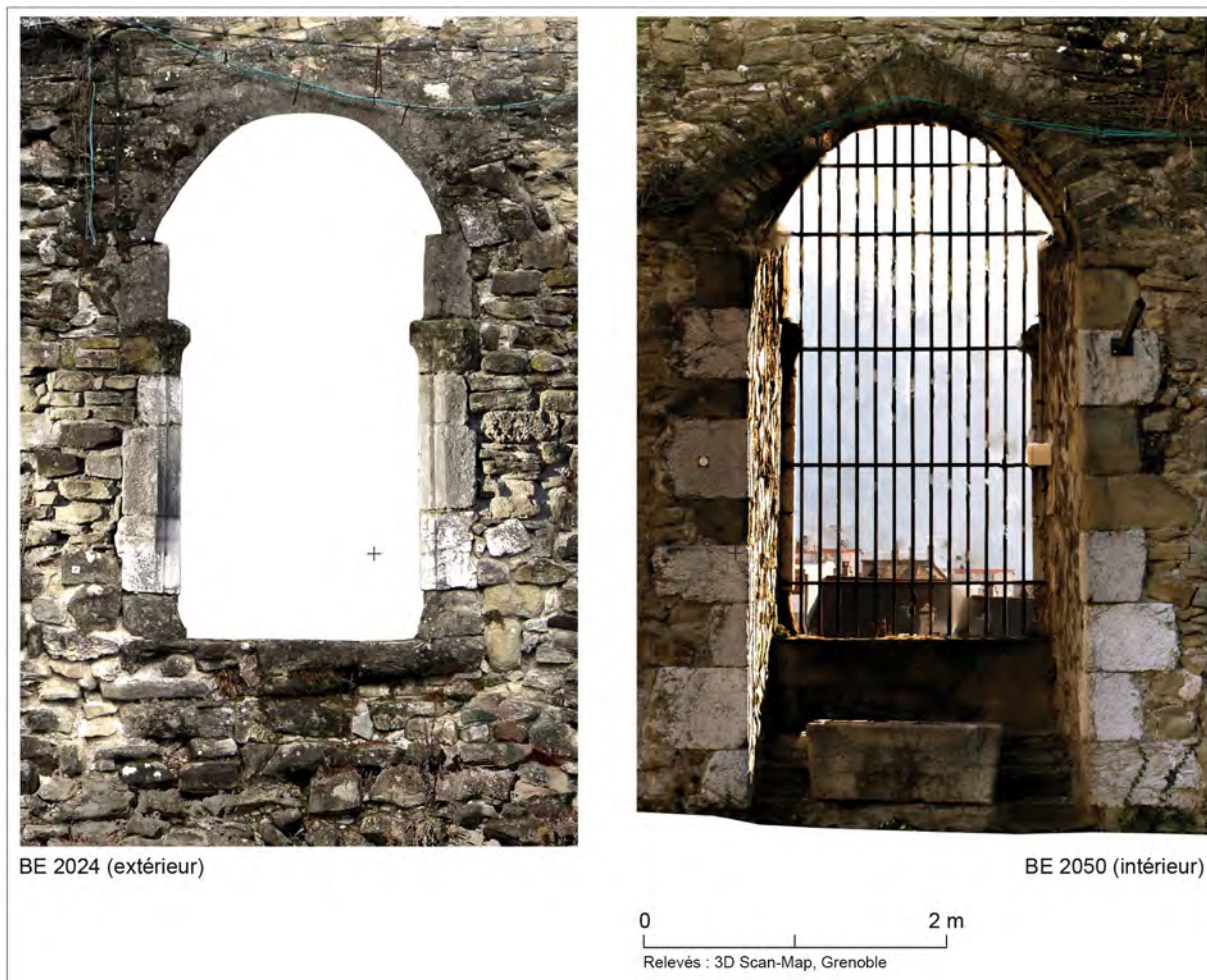
Fig. 16 : Baie ouest de la courtine sud, avec son arc refait au XXe siècle. Orthophotographies : 3D Scan-Map, Grenoble.
