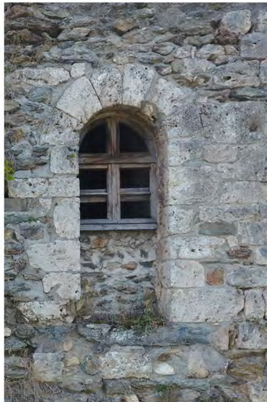
Vue d'ensemble de la porte transformée en fenêtre.
