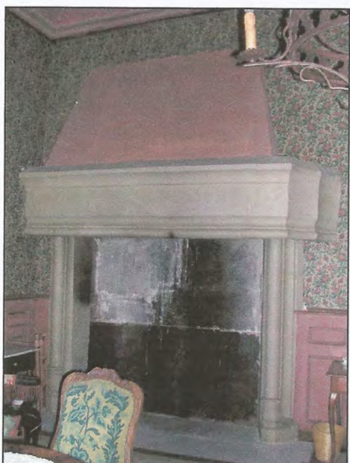
Cheminée TYPE 2 Cheminée moulurée avec moulure en tore et en doucine. Cambre Nord-Est du deuxième étage (XVI e s.)
