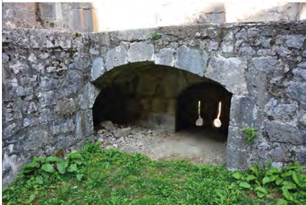
Chambre de tir dans l'angle nord-ouest du boulevard : deux canonnières doubles sont desservies par la même casemate.
