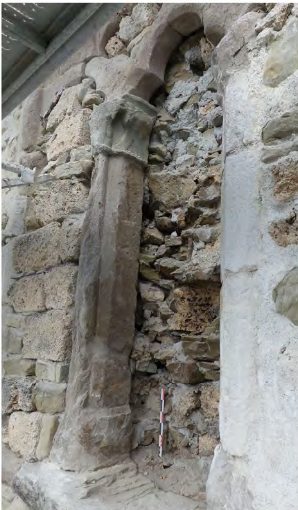
Meneau, en cours de dégagement
