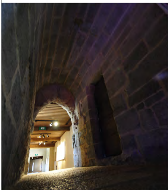
Couloir menant à la porte d'accès à la courtine ouest et porte de l'escalier en vis intramural.
