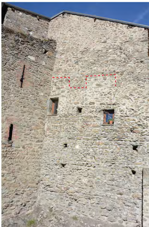
Fig. 10 : Porte Tarine. Insertion de la tour porte dans un bâti existant. Clichés : J. Laidebeur, E. Chauvin-Desfleurs.
