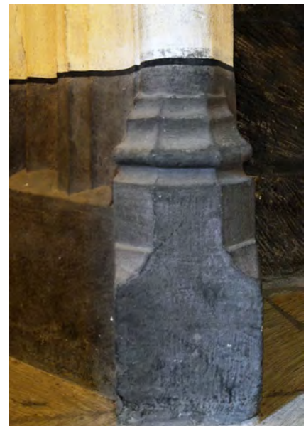
Fig. 37 : Château d'Annecy. Tour et Logis Perrière (ES 6 et 7), cheminée de la salle est (R+2), détail de la base du piédroit sud.
