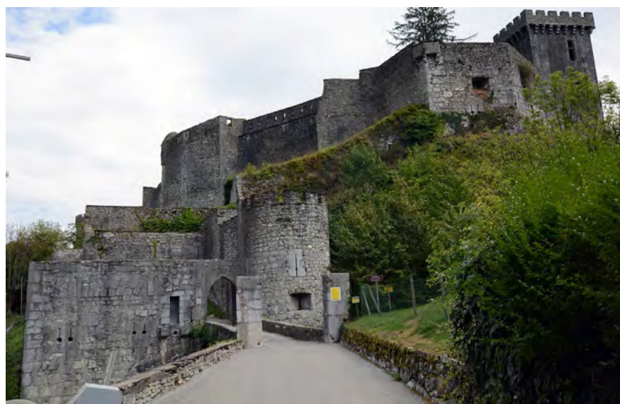
Fig. 23 : Château de Miolans. Le boulevard d'entrée depuis le pont actuel. Cliché : E. Chauvin-Desfleurs
