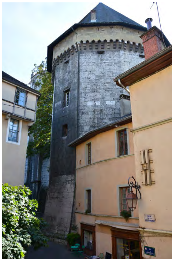
Fig. 24 : Château de Chambéry. Vue sur la Tour Trésorerie depuis le nord-ouest. Cliché : L. D'Agostino
