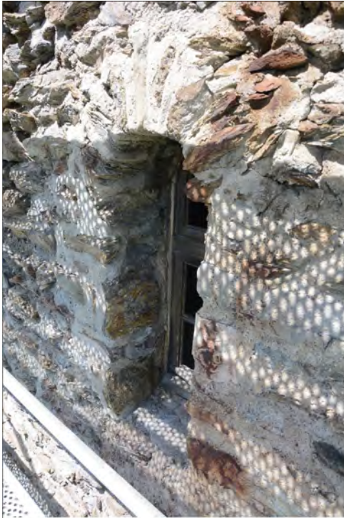
Piédroits et claveaux en schiste de la baie FEN 13 (M 4). Restauration au ciment et insertion de modules en calcaire (UC 1006).
