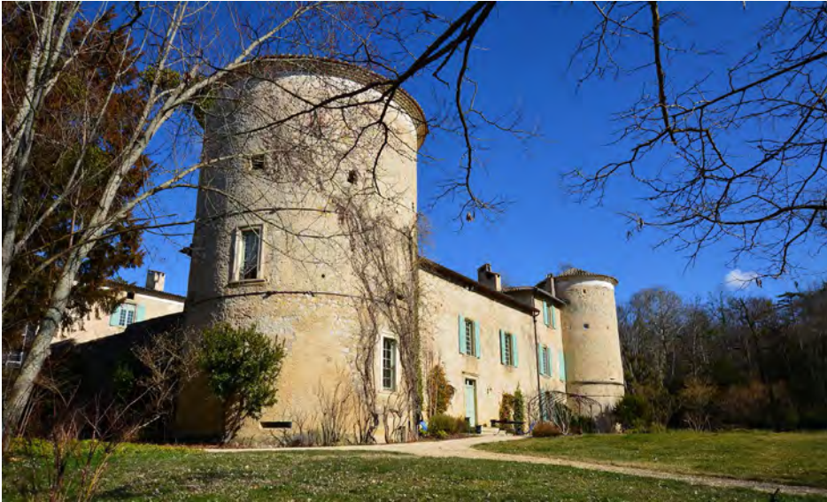
Fig. 1 : Château de Vachères (Montclar-sur-Gervanne, Drôme).
