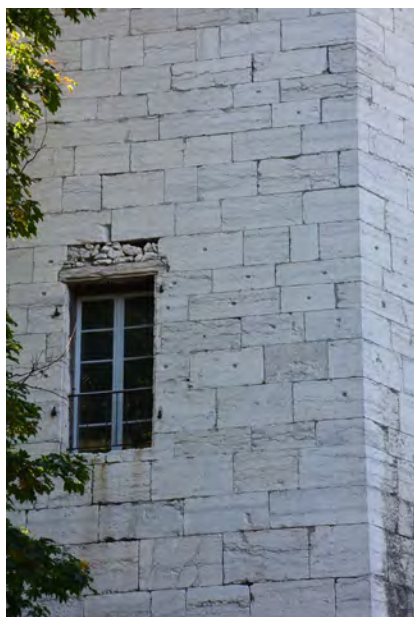
Fig. 49 : Château de Chambéry. Une fenêtre du premier étage de la Tour Trésorerie et les trous de préhension. Cliché : L. D'Agostino.
