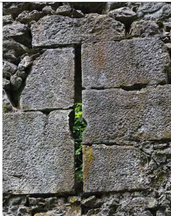
Arquebusière de la tour sud, avec barre d'appui sous l'orifice de tir. La cassure est-elle volontaire pour élargir le champ de tir ou est-elle due à l'utilisation ?
