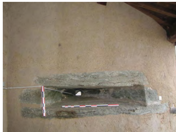
Fig. 39 : Château de Buffavent (Lully, 74). Canonnière de type 1 BE1052 (tour nord), depuis l'extérieur. Cliché : A. Mauveaux
