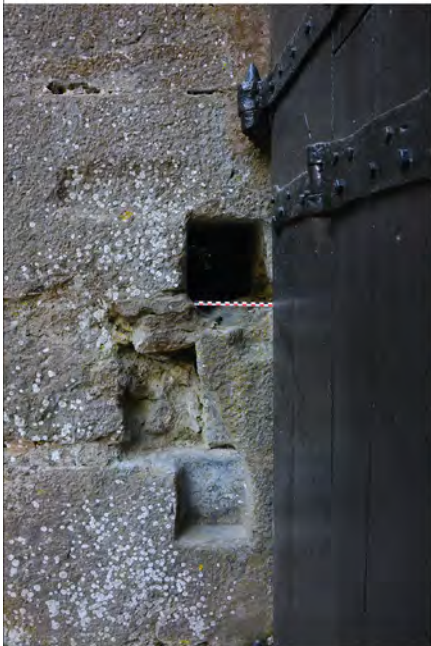
Encoches pour barres de fermeture de la porte.
