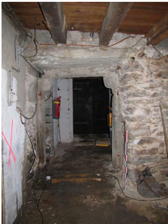
Fig. 25 : Château de Buffavent (Lully, 74). Porte PR1031 depuis l'intérieur du logis de la phase 2. Cliché : M. Caillet
