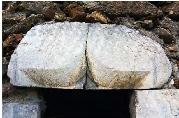
Détail : arc en accolade et traces d'un badigeon jaune.
