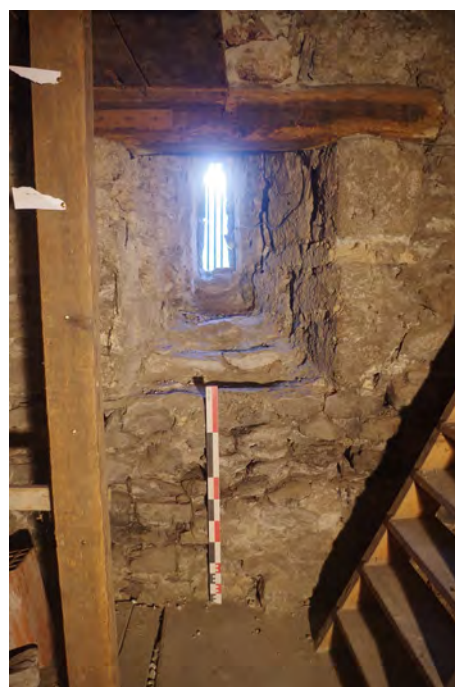
Fig. 10 : Maison forte de La Frasse (Sallanches, 74). Face interne de la baie ogivale septentrionale. Clichés : L. Benoit.
