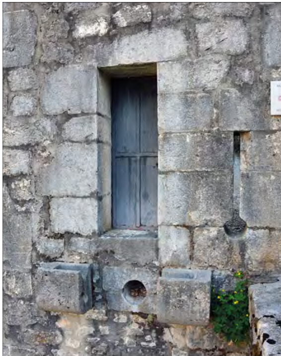
Guichet (porte piétonnière) à pont-levis et canonnères.
