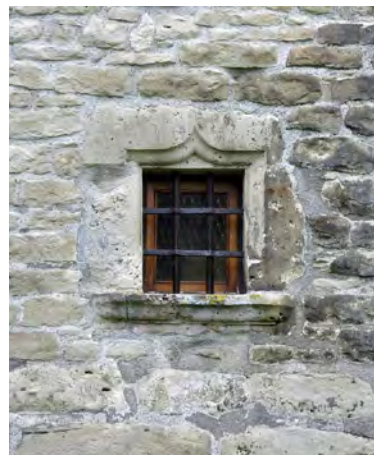
Fig. 18 : Château de Regard, Clermont (74). Baie à doucine et linteau à arc en accolade au rez-de-chaussée du pavillon sud-ouest. Cliché : L. D'Agostino.
