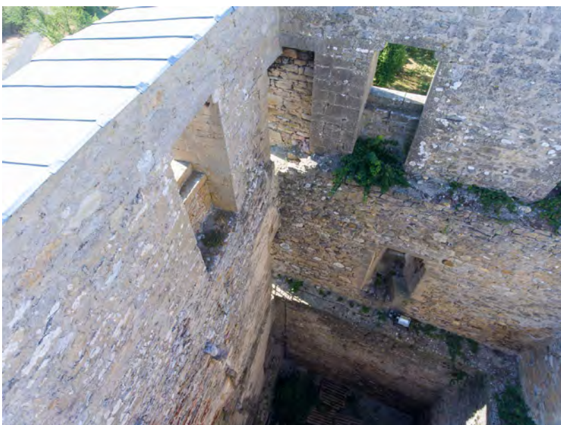
Fig. 27 : Tour de Saint-Denis. 2e étage, porte, baies créneaux et ressaut. Cliché : J. Laidebeur.
