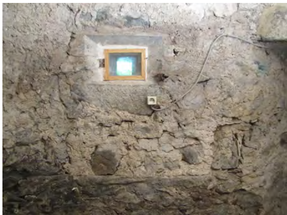
Fig. 40 : Château de Buffavent (Lully, 74). Archère-canonnière de type 1 BE1048 remplacée par la canonnière de type 1 BE1027 (tour sud), depuis l'intérieur. Cliché : M.Caillet
