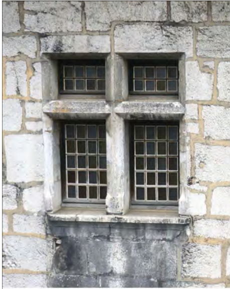
Fenêtre à croisée de meneau du deuxième étage.
