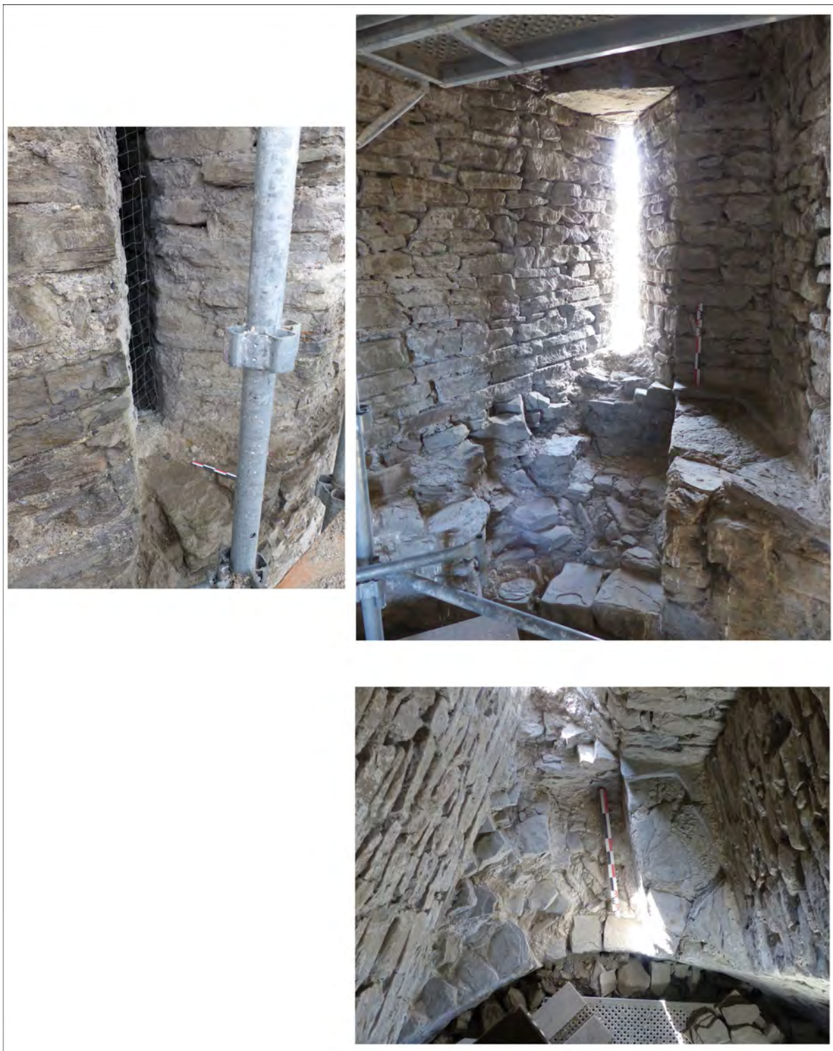
Fig. 30 : Tour nord-est : l'archère ou baie à coussiège BE 4018 vue de l'extérieur vers le nord (en haut à gauche) et de l'intérieur vers le sud-est et en plan (à droite). Clichés : S. Bocquet, Inrap
