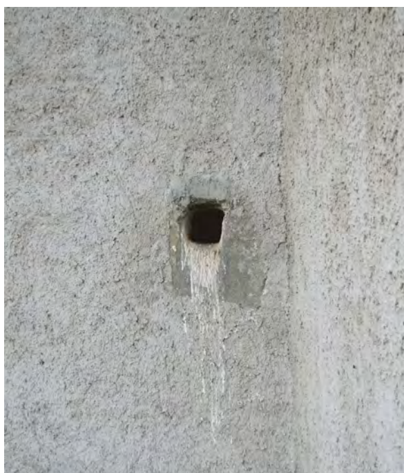
Fig. 44 : Château de Buffavent (Lully, 74). Canonnière de type 2 BE3028 (sud, 1er étage), depuis l'extérieur. Cliché : M. Caillet
