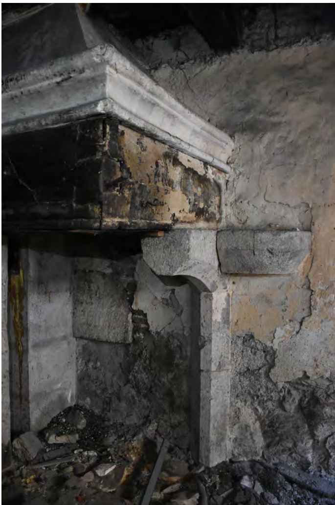
Fig. 10 : Château de Dhéré. Cheminée de la maison forte de Loche à Magland. Cliché : L. Benoit.
