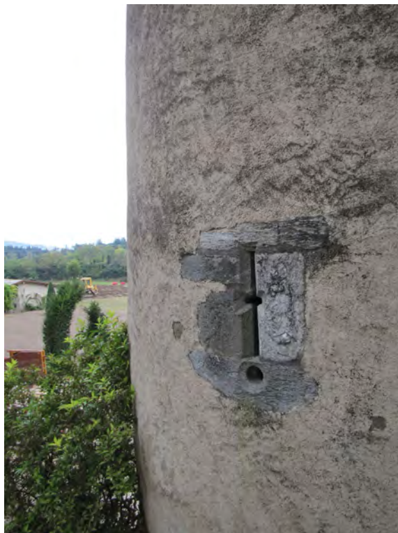
Fig. 36 : Château de Buffavent (Lully, 74). Archère-canonnière BE2067 de type 2 depuis l'extérieur. Cliché : M. Caillet
