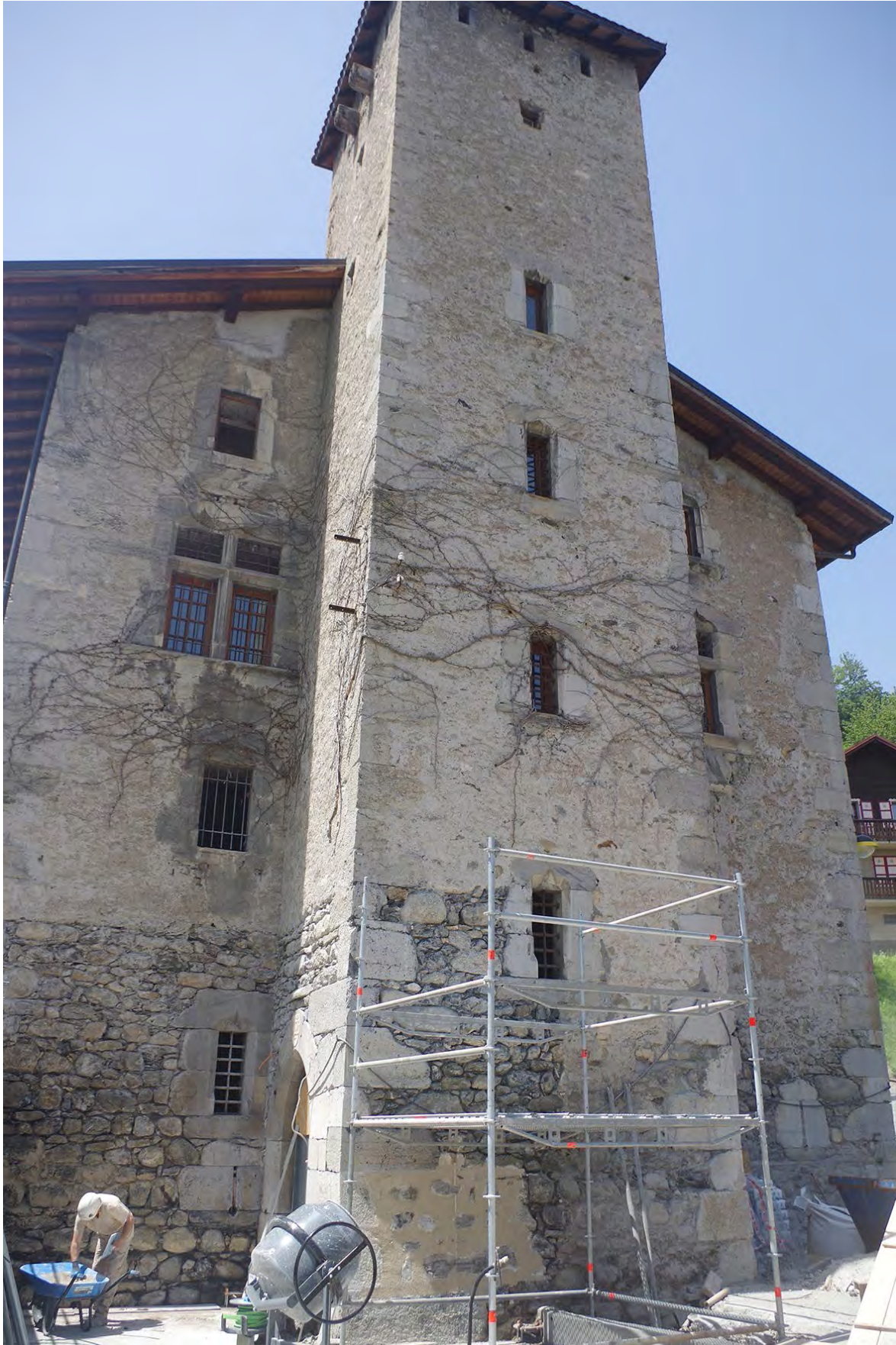
Fig. 1 : Maison forte des Rubins (Sallanches, 74). Vue générale de la maison forte. Clichés : L. Benoit.
