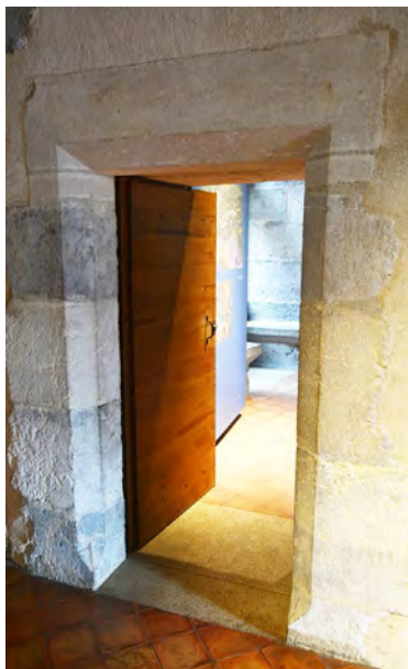
Fig. 25 : Château d'Annecy. Tour et Logis Perrière (ES 6 et 7), porte de communication intérieure (R+2). Doc. : L. D'Agostino.
