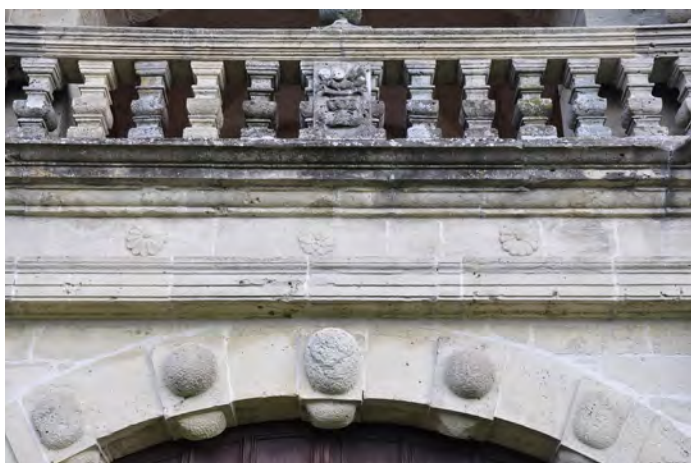
Fig. 36 : Château de Regard, Clermont (74). Arc surbaissé bagué à bossages, entablement à fleurons et balustrade de la loggia. Cliché : L. D'Agostino.
