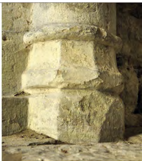
Escalier à vis et base prismatique identiques dans les deux pavillons
