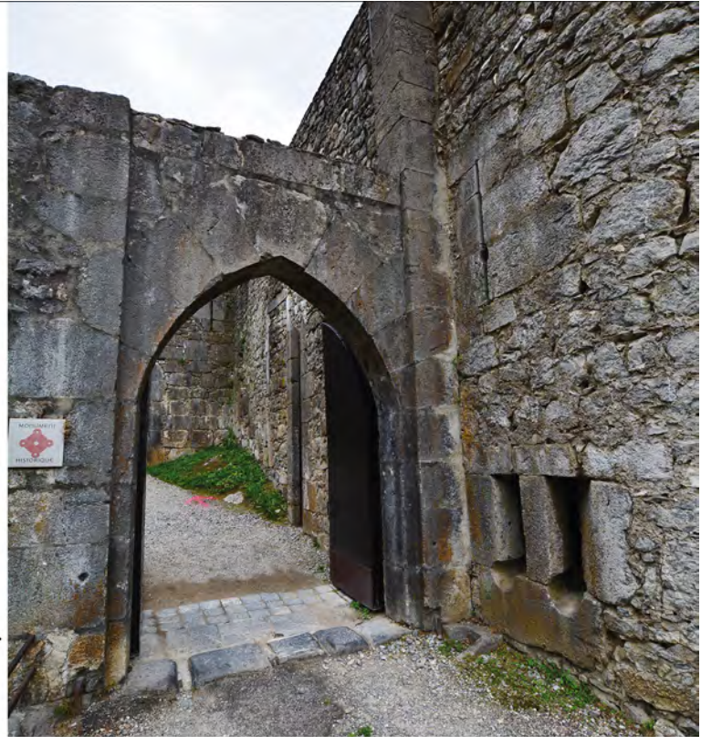
Encadrement de la porte charretière et feuillure du tablier du pont.
