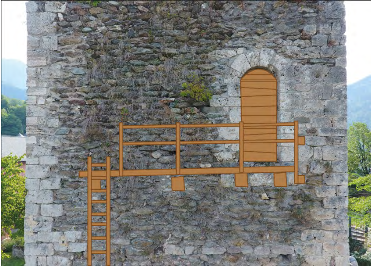
Fig. 24 : Tour Sarrasine. Proposition de restitution du système d'accès. Cliché : J. Laidebeur, DAO : E. Chauvin-Desfleurs.
