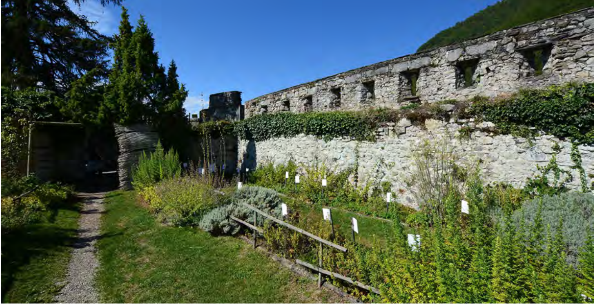
Fig. 28 : Château de Miolans. Chemin de ronde et créneaux de fusillade au sommet de la courtine nord. Cliché : L. D'Agostino
