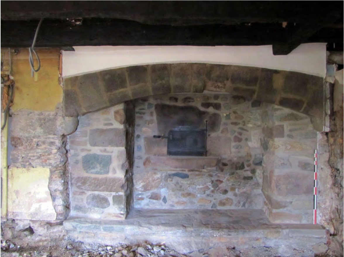
Fig. 12 : Château de Buffavent (Lully, 74). Vue générale de la cheminée CH1045. Cliché. : M. Caillet, Hadès
