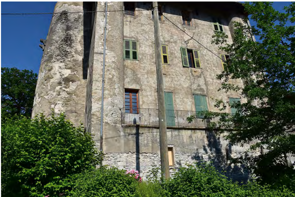
Fig. 6 : Maison forte de La Frasse (Sallanches, 74). Vue générale de la façade est de la maison forte. Cliché : L. Benoit.
