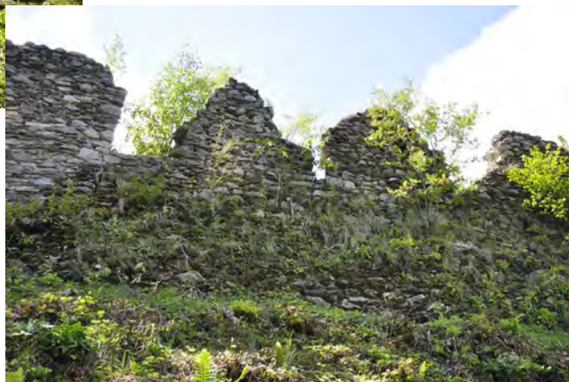
Fig. 12 : Château de Saint-Michel-du-Lac, Les Houches (74). Fentes de tir en moellons bruts visibles depuis la pente. Cliché : L. D'Agostino.
