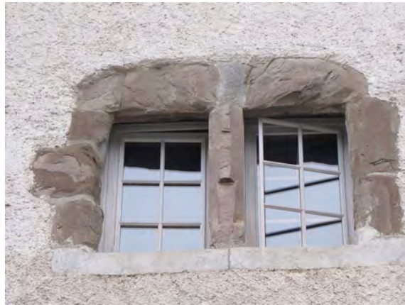
Fig. 9 : Château de Buffavent (Lully, 74). Baie du 2eme étage depuis l'extérieur. Cliché. : A. Mauveaux, Hadès
