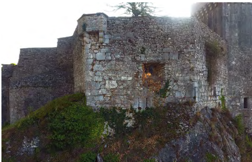
Fig. 22 : Château de Miolans. Détail du boulevard ouest et position des canonnières successives. Cliché : J. Laidebeur
