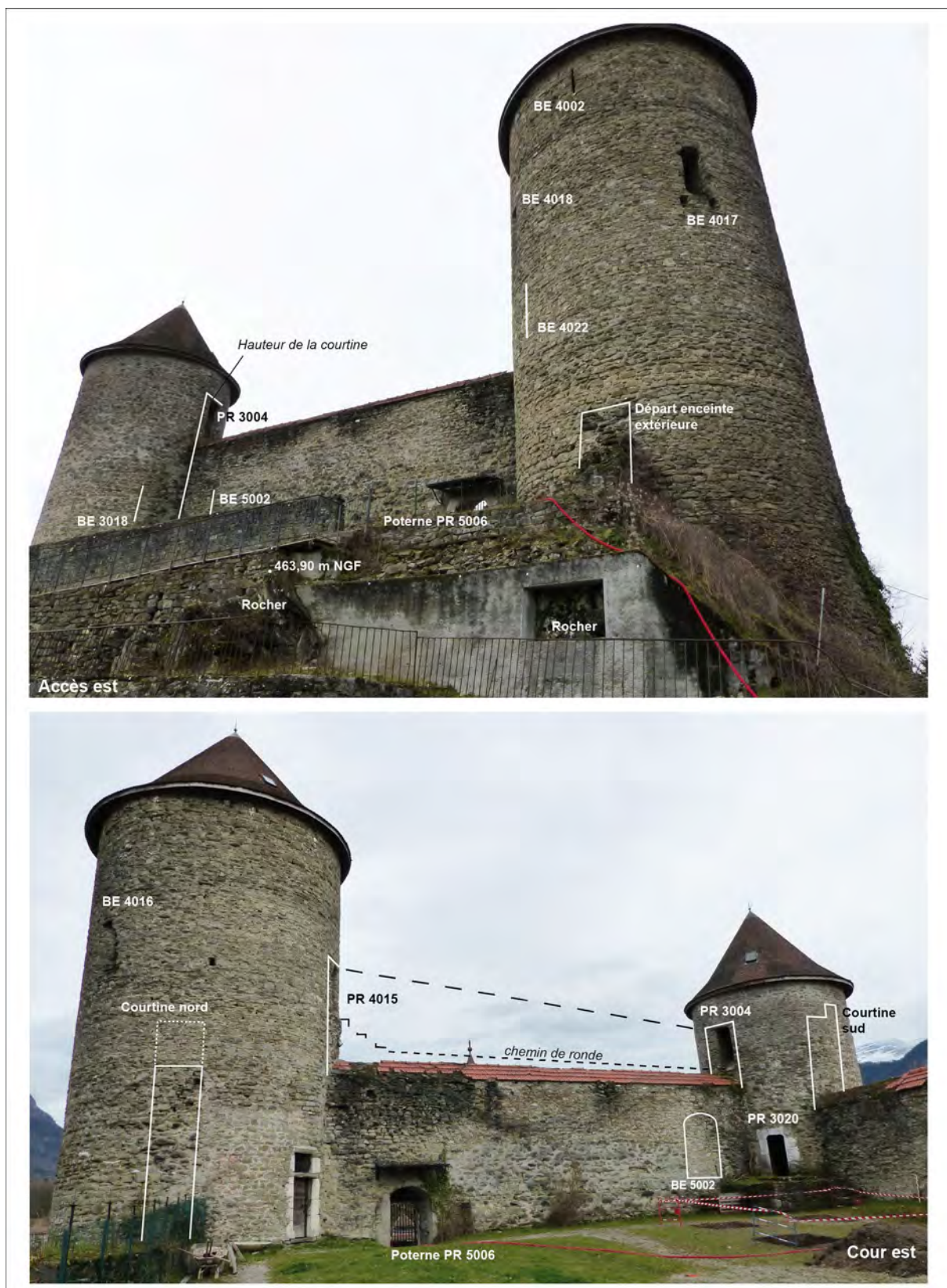
Fig. 21 : Vue des tours et de la courtine est depuis les abords nord-est et vers le sud-ouest (en haut), et depuis la cour est et vers le sud-est (en bas), le 3 mars 2017 (avant piquage et travaux). Clichés : S. Bocquet, Inrap
