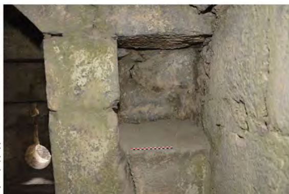
Fig. 55 : Château de Miolans. Cour haute, courtine est. Détails de l'arquebusière / canonnère sud. Clichés : E. Chauvin-Desfleurs
