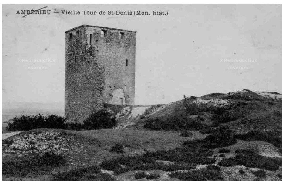
Fig. 17 : Tour de Saint-Denis. Topographie du site au début du XXe siècle vu depuis le sud-est. Doc. : AD Ain, 5 Fi 345-13.
