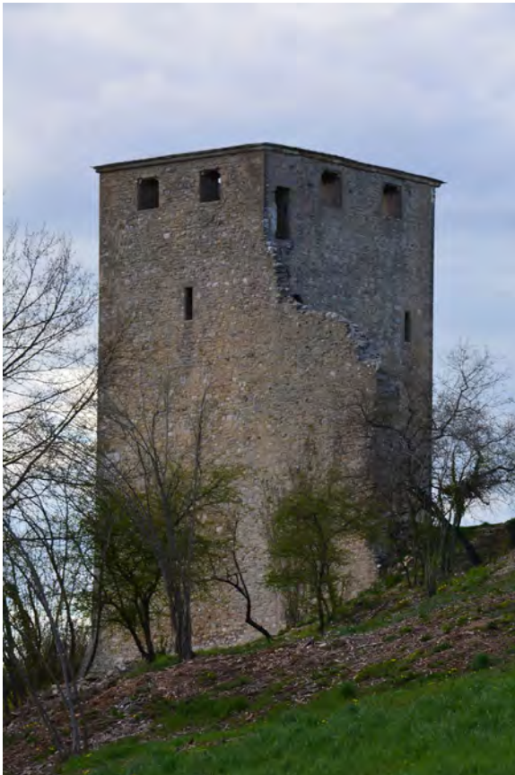
Fig. 6 : Tour de Saint-Denis. Angle sud-est de la tour et départ de la courtine sud. Cliché : L. D'Agostino.
