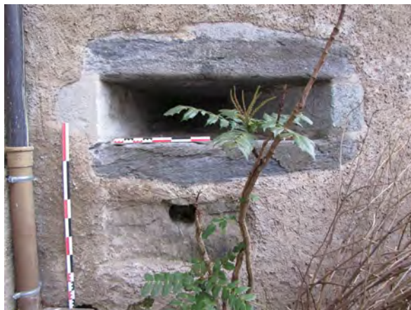
Fig. 41 : Château de Buffavent (Lully, 74). Archère-canonnière de type 1 BE1073 remplacée par la canonnière de type 1 BE1054 (tour sud), depuis l'intérieur. Cliché : M. Caillet
