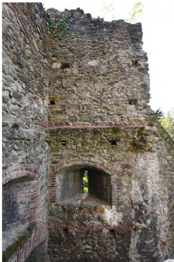
Mur latéral avec son archère en sifflet, les indices des niveaux de plancher et les trous de boulin traversants.
