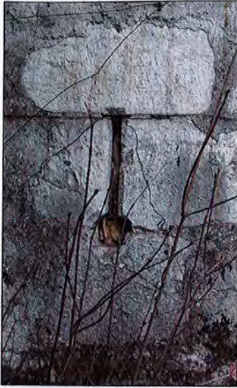
Archère-canonnière à trou inférieur située sur le parement Ouest de la tour Sud (rez-de-chaussée).
