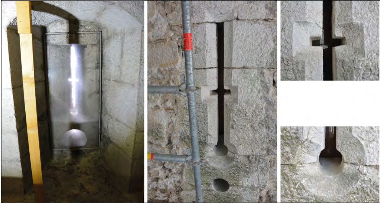
Fig. 39 : Château d'Annecy. Archère-canonnrière du rez-de-chaussée de la Tour « sans nom » (UC 29.04). Doc. : E. Chauvin-Desfleurs.
