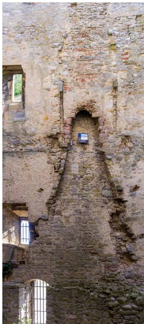
Fig. 24 : Tour de Saint-Denis. 1er et 2e étage, vestiges de deux cheminées superposées. Cliché : J. Laidebeur.
