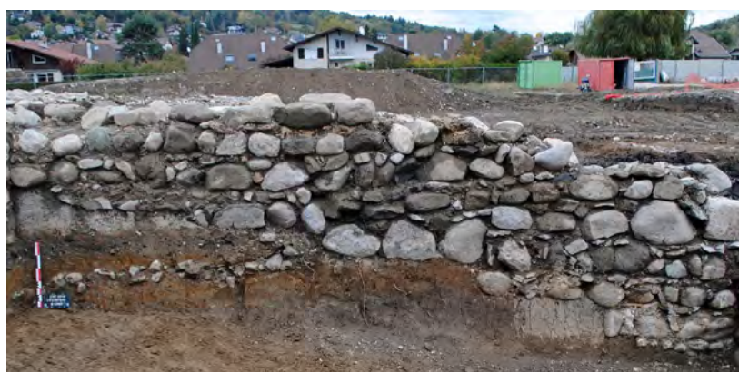
Fig. 16 : Château d'Épagny. Photographie du mur F1004 fondé en escalier. Cliché : Équipe de fouille.
