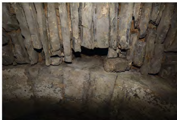
Event pour les fumées aménagé dans la voûte à l'entrée de la niche ébrasée.
