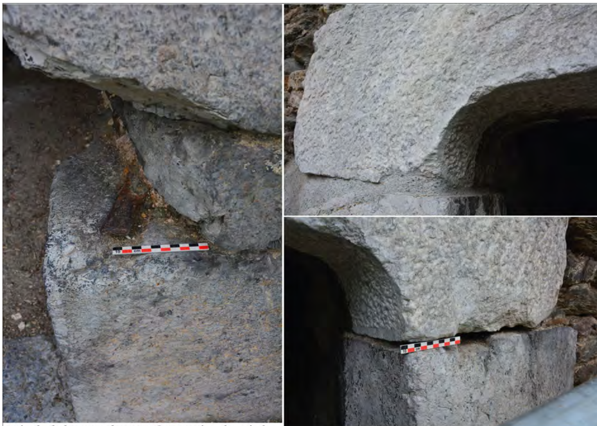
Détails de la porte du R+0 POR 8 : pièce de métal, traces de taille et trou d'ancrage.
