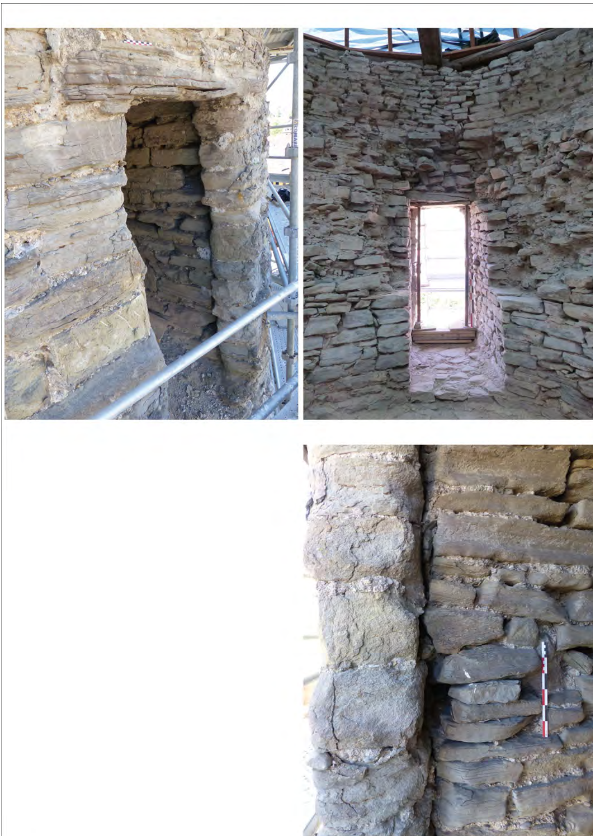
Fig. 45 : Tour sud-est : la porte PR 3004 depuis l'extérieur vers le sud-est (à gauche) et vue de l'intérieur vers le nord-est (en haut à droite), avec détail sur le contact du piédroit et de l'embrasure est. Clichés : S. Bocquet, Inrap
