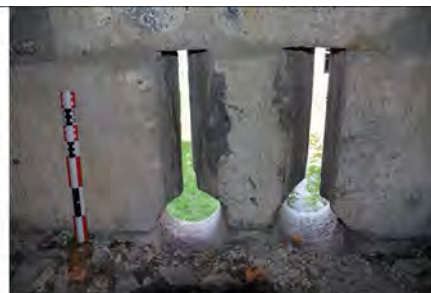
Canonnière double à axes divergents.
