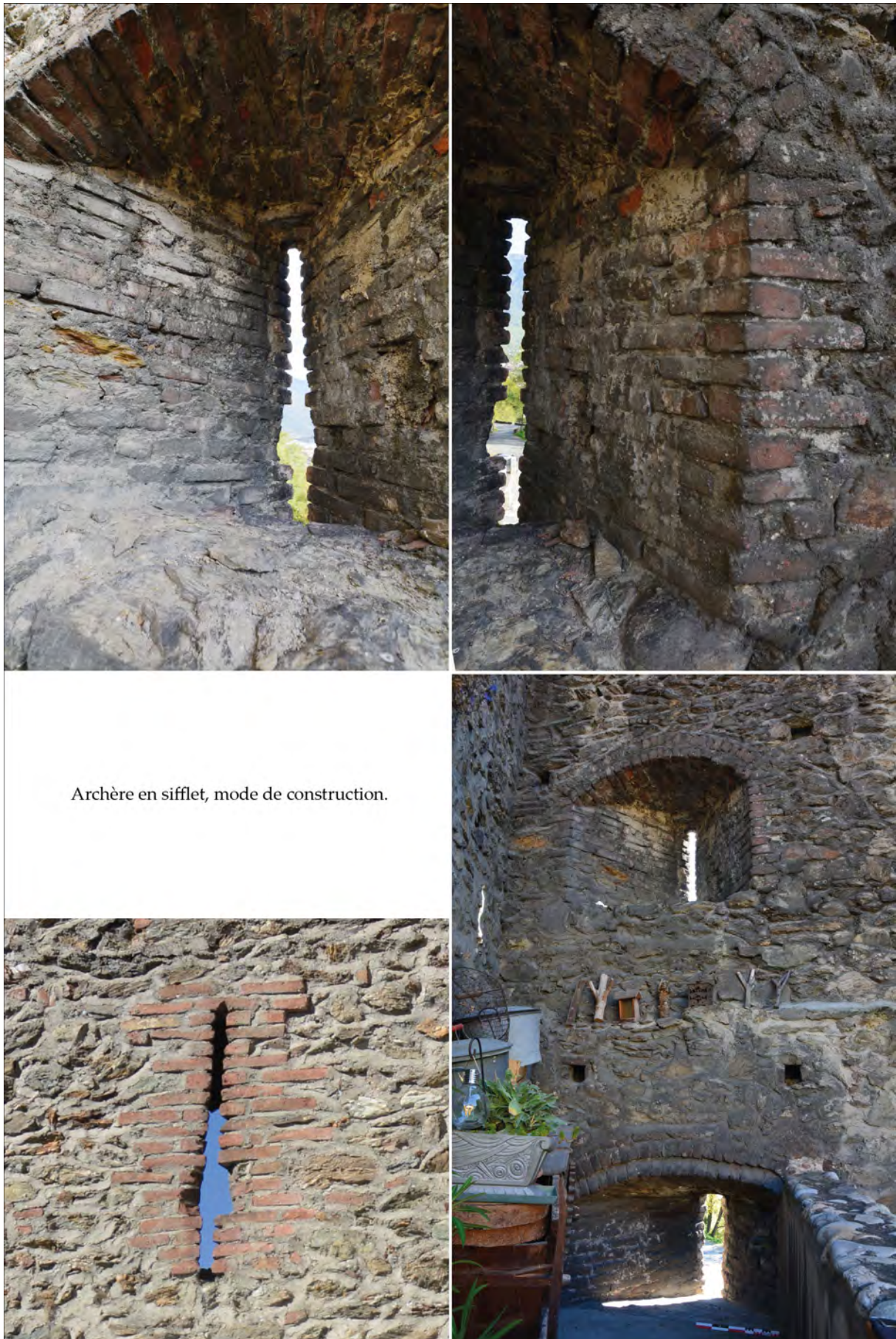
Fig. 15 : Porte Tarine. L'archère en sifflet du 2e étage. Clichés : L. D'Agostino, E. Chauvin-Desfleurs.
