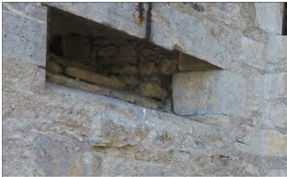
Canonnière à ébrasement externe plongeant au cinquième étage de la tour maîtresse, dans le mur nord.
