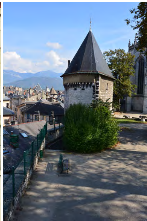
Fig. 8 : Château de Chambéry. Emplacement de l'escalier d'accès des Salles basses, le long de la courtine nord du château. Cliché : E. Chauvin-Desfleurs.
