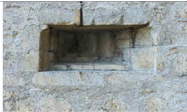
Canonnière à ébrasement externe orienté vers le nord (en direction du pont) au troisième étage de la tour maîtresse, dans le mur nord.
