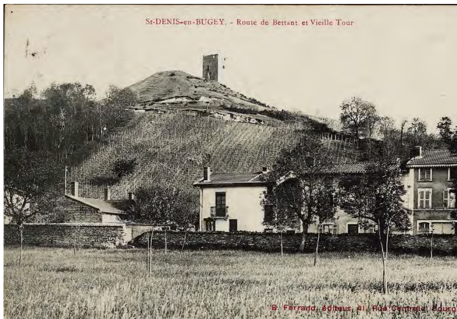
Fig. 15 : Tour de Saint-Denis. Le site en 1909 vu depuis le nord-ouest. Source : 5 Fi 345-20 Archives de l'Ain.
