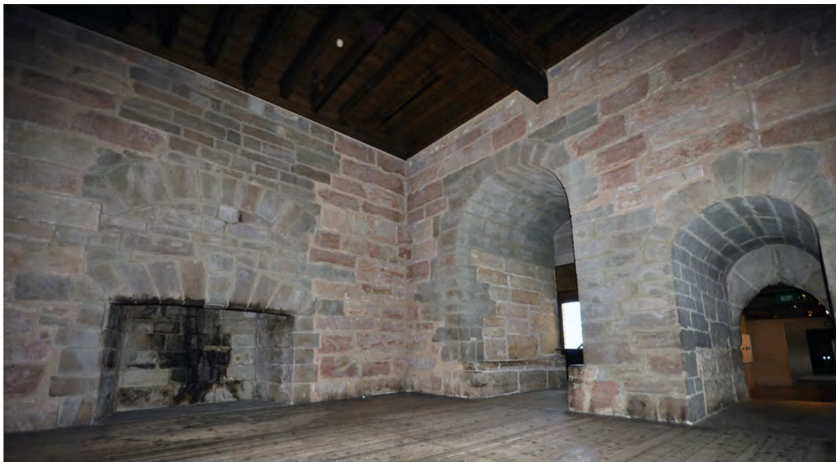
Deuxième étage, murs ouest et nord : cheminée intramurale baie à coussièges et porte d'accès à la courtine ouest.
