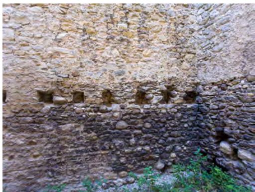
Fig. 22 : Tour de Saint-Denis. RDC, trous d'ancrage du plancher du 1er étage. Cliché : J. Laidebeur.
