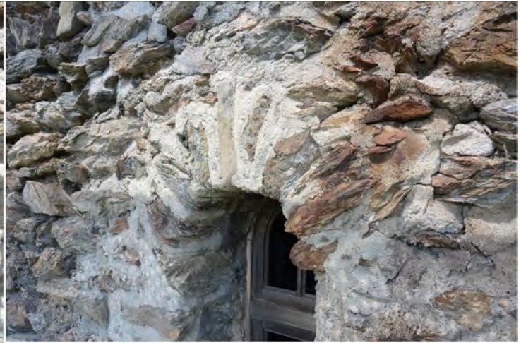
Piédroits et claveaux en schiste de la baie FEN 13 (M 4). Restauration au ciment et insertion de modules en calcaire (UC 1006).
