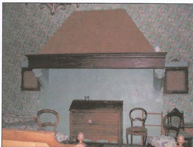
Cheminée TYPE 1 Cheminée sur consoles moulurées flanquée de tablettes. Chambre Sud-Est du deuxième étage (XVI e s.)
