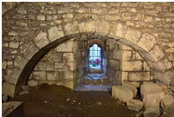
Fig. 21 : Château de Chambéry. Deuxième arcade en sous-œuvre de la grande arcade nord et baie trilobée. Cliché : E. Chauvin-Desfleurs.
