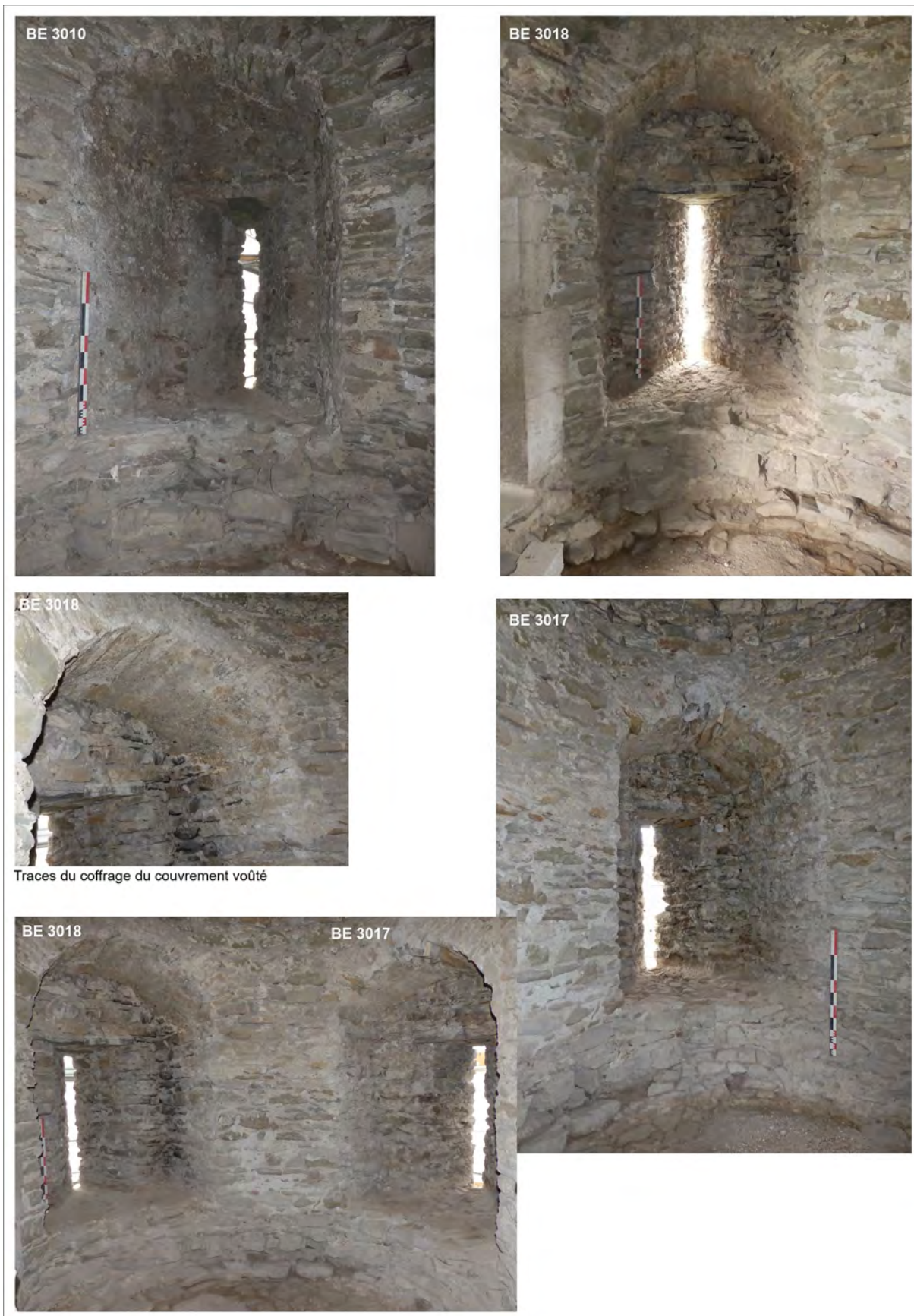
Fig. 41 : Tour sud-est : les archères du niveau intermédiaire BE 3010 vers le sud-ouest, BE 3018 vers le nord et BE 3017 vers le sud-est. Clichés : S. Bocquet, Inrap
