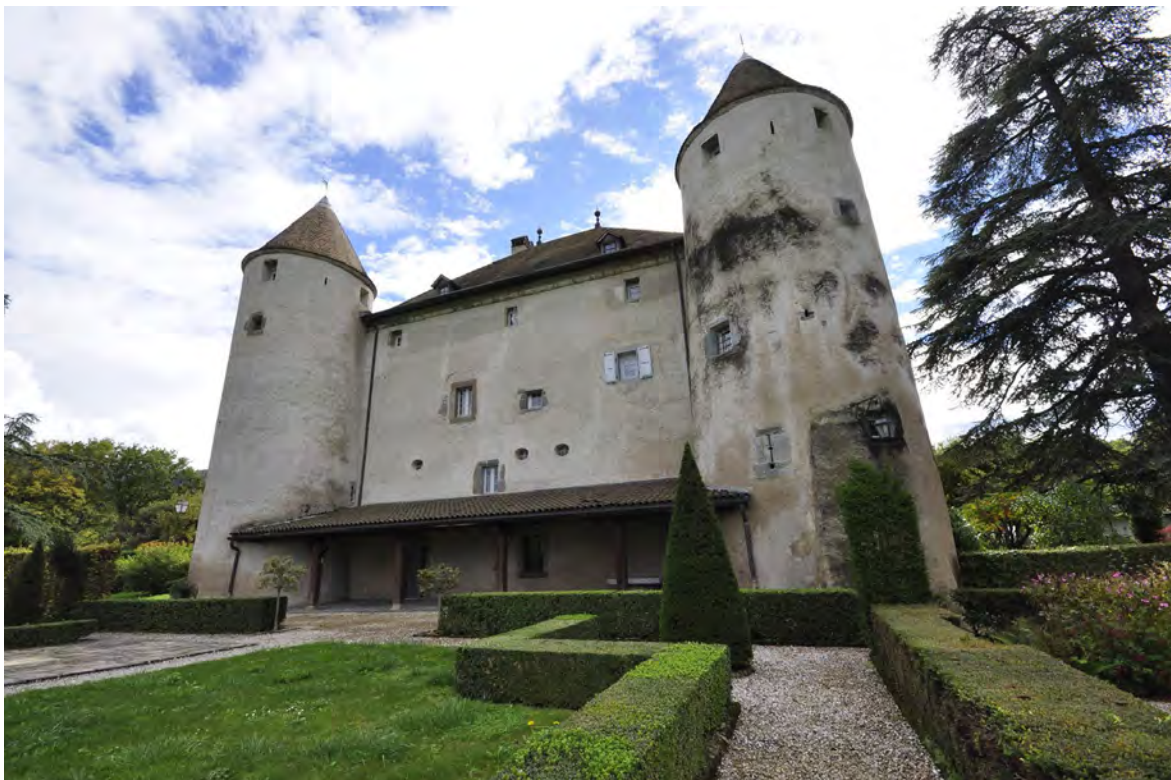
Fig. 4 : Château de Buffavent (Lully, 74). Vue générale du château depuis le nord. Cliché. : A. Mauveaux, Hadès
