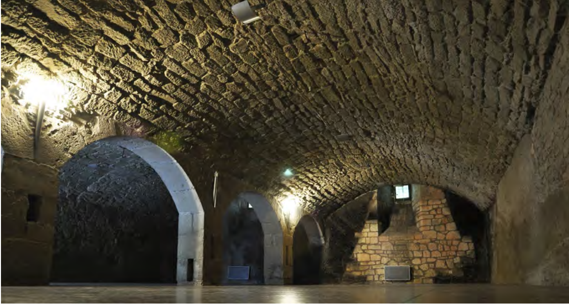
Fig. 9 : Château de Regard, Clermont (74). Vue générale du cellier à deux vaisseaux voûtés en berceau surbaissé. Cliché : L. D'Agostino.
