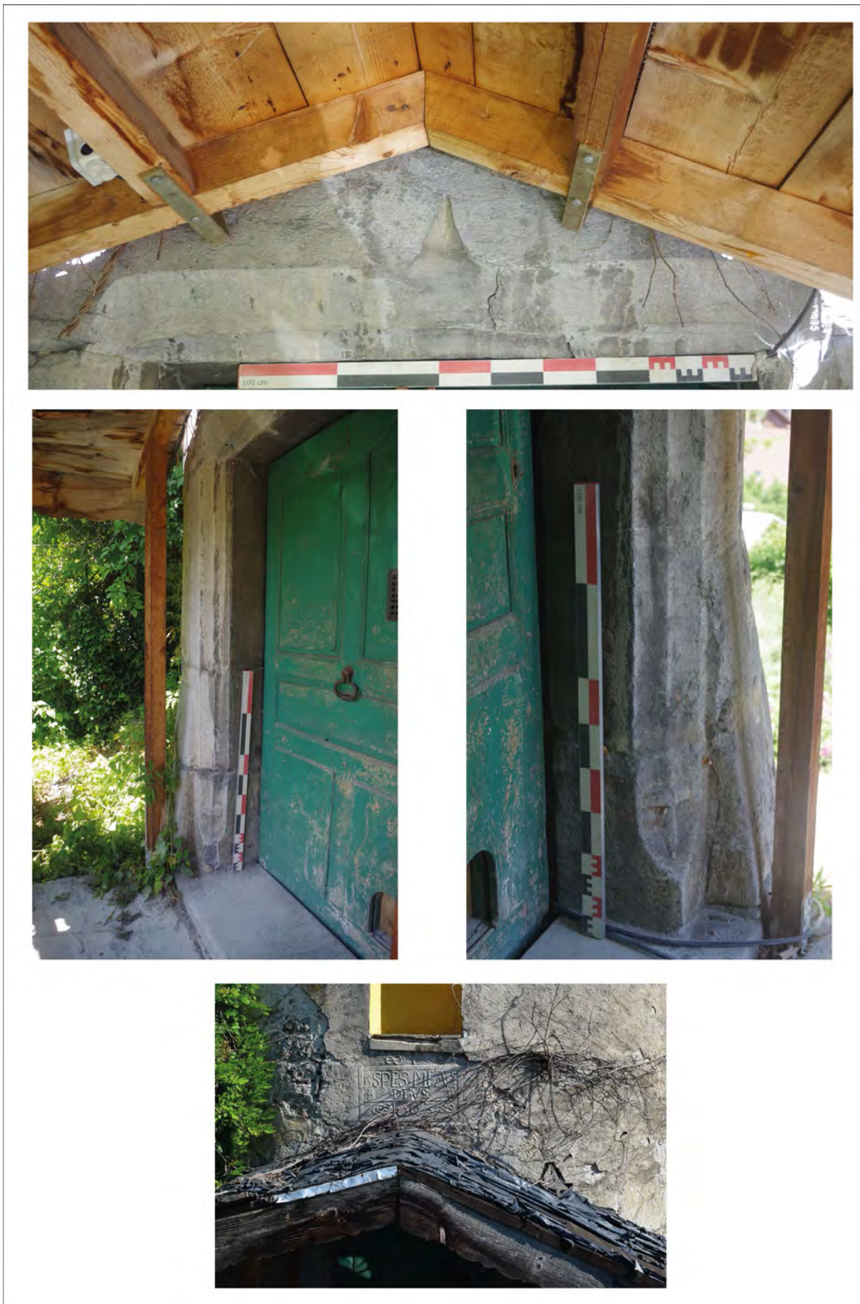
Fig. 16 : Maison forte de La Frasse (Sallanches, 74). Porte d'entrée de la tour d'escalier. Clichés : L. Benoit et J. Lair.
