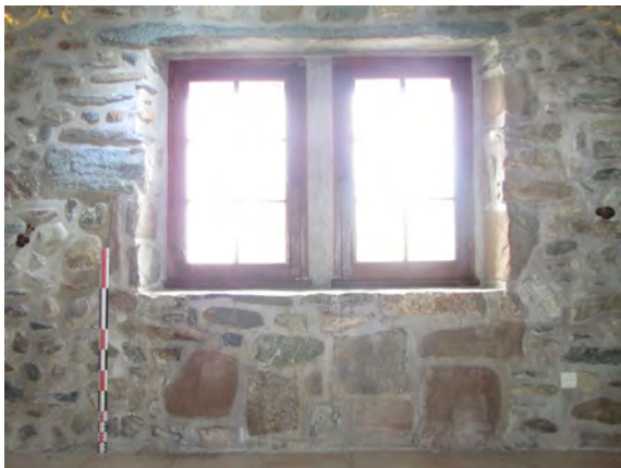
Fig. 8 : Château de Buffavent (Lully, 74). Baie du 2eme étage depuis l'intérieur. Cliché. : M. Caillet, Hadès
