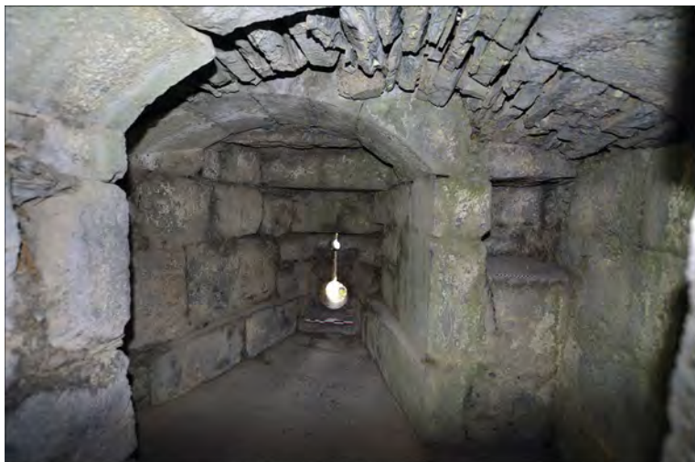
Chambre de tir casematée au sud du portail.
