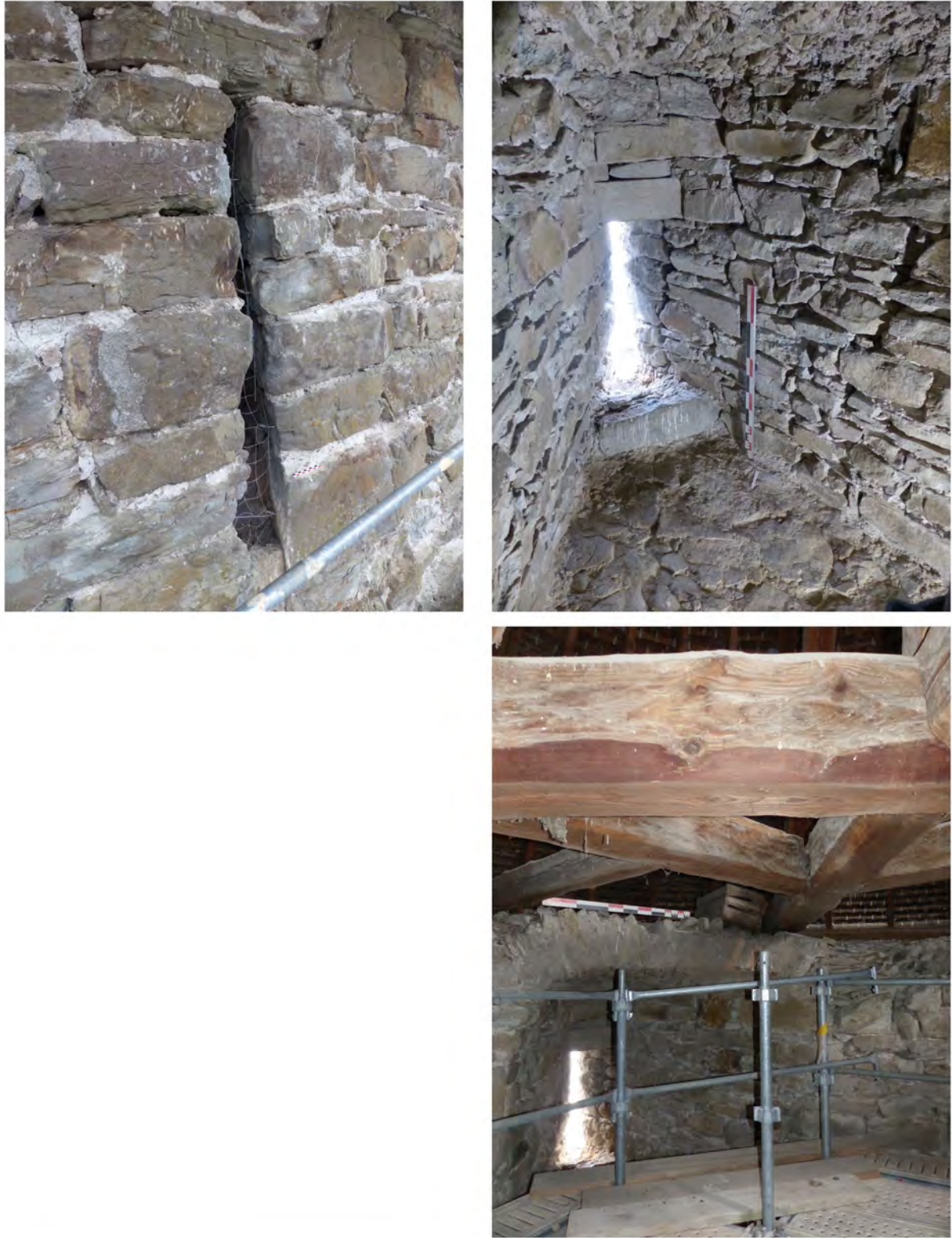
Fig. 32 : Tour nord-est : l'archère BE 4002 depuis l'extérieur (en haut à gauche) et côté intérieur (en haut et en bas à droite). Clichés : S. Bocquet, Inrap
