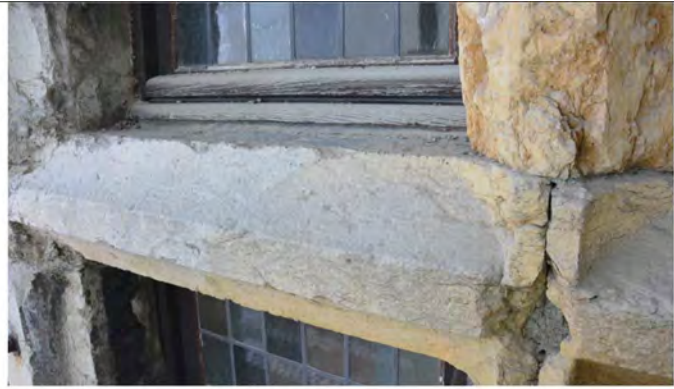
Traverse à gorges et trou de fixation de grille
