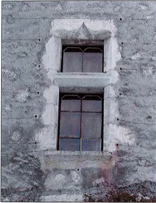
Fenêtre rectangulaire à traverse surmontée d'un linteau à accolade (XVI e s.)
