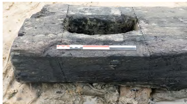
Fig. 27 : Château d'Épagny. Lignage et piquage. Mortaise de la sablière F1114. Cliché : F. Blondel.
