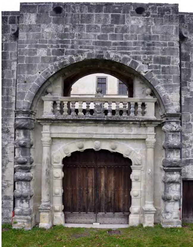
Fig. 34 : Château de Regard, Clermont (74). Portail d'honneur de la façade sud. Cliché : E. Chauvin-Desfleurs.
