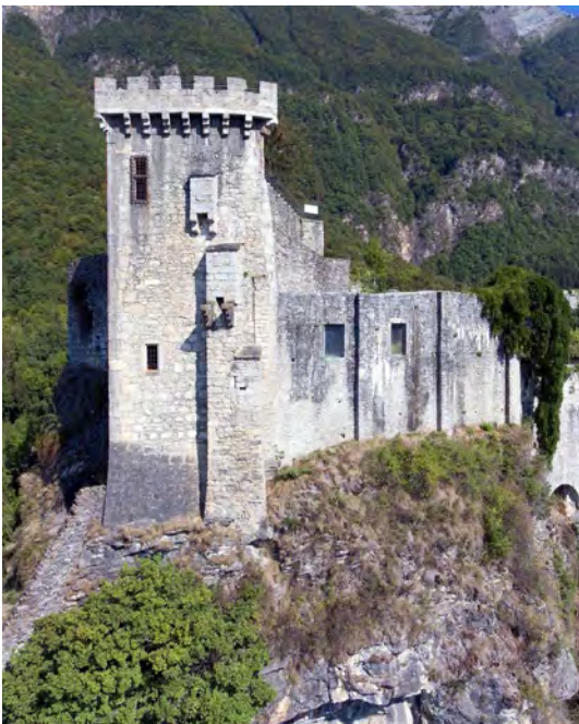
Fig. 11 : Château de Miolans. La tour Saint-Pierre et les bâtiments romans. Cliché : J. Laidebeur
