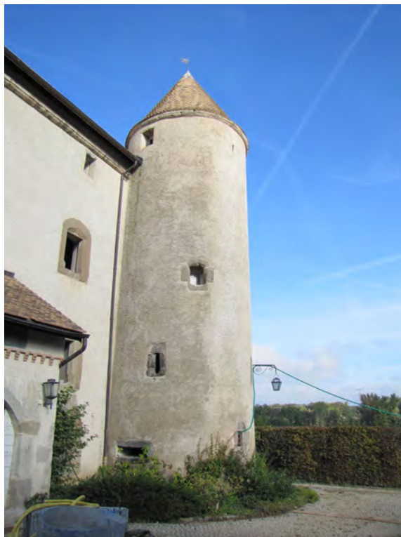
Fig. 31 : Château de Buffavent (Lully, 74). La tour est et ses ouvertures. Cliché : M. Caillet
