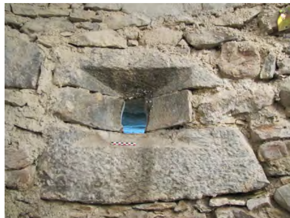
Fig. 38 : Château de Buffavent (Lully, 74). Canonnière de type 1 BE1062 (tour ouest), depuis l'intérieur. Cliché : M. Caillet
