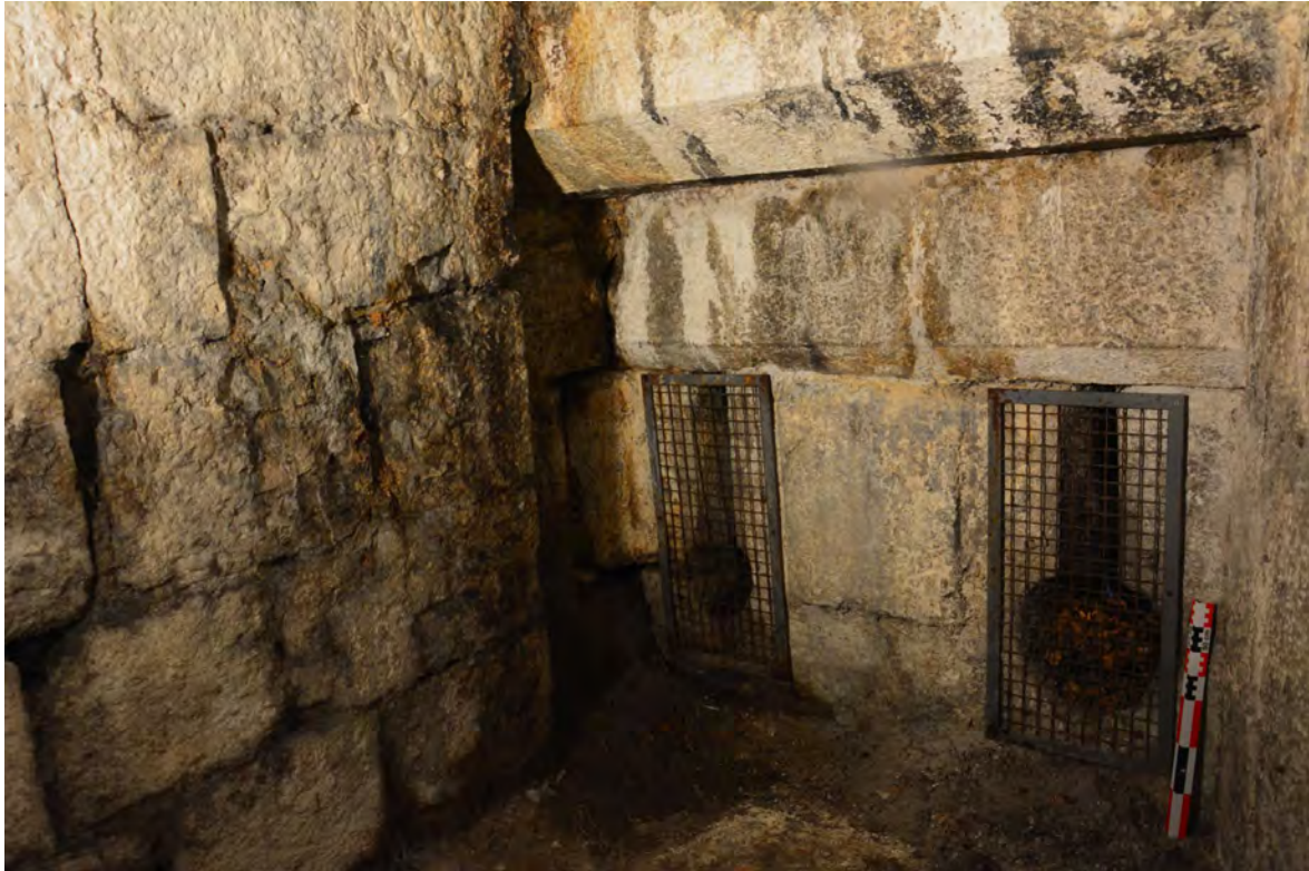
Fig. 45 : Château de Chambéry. La canonnière double CAN 7 de la salle d'artillerie. Cliché : E. Chauvin-Desfleurs.
