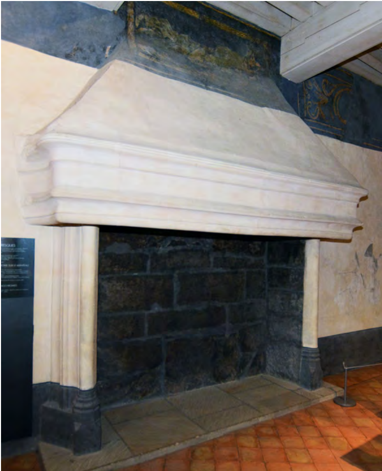
Fig. 36 : Château d'Annecy. Tour et Logis Perrière (ES 6 et 7), cheminée de la salle est (R+2). Doc. : L. D'Agostino.
