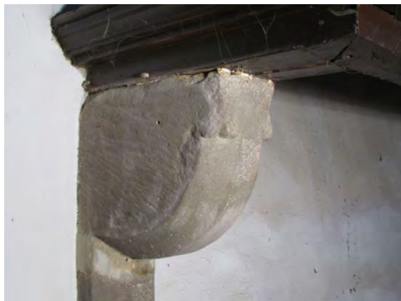
Fig. 20 : Château de Buffavent (Lully, 74). Cheminée de l'étage CH2050, détail du corbeau ouest. Cliché : M. Caillet, Hadès
