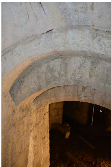
Fig. 35 : Château de Chambéry. Succession d'arrières-voussures et arcs chanfreinés de l'escalier de la salle d'artillerie. Cliché : L. D'Agostino.
