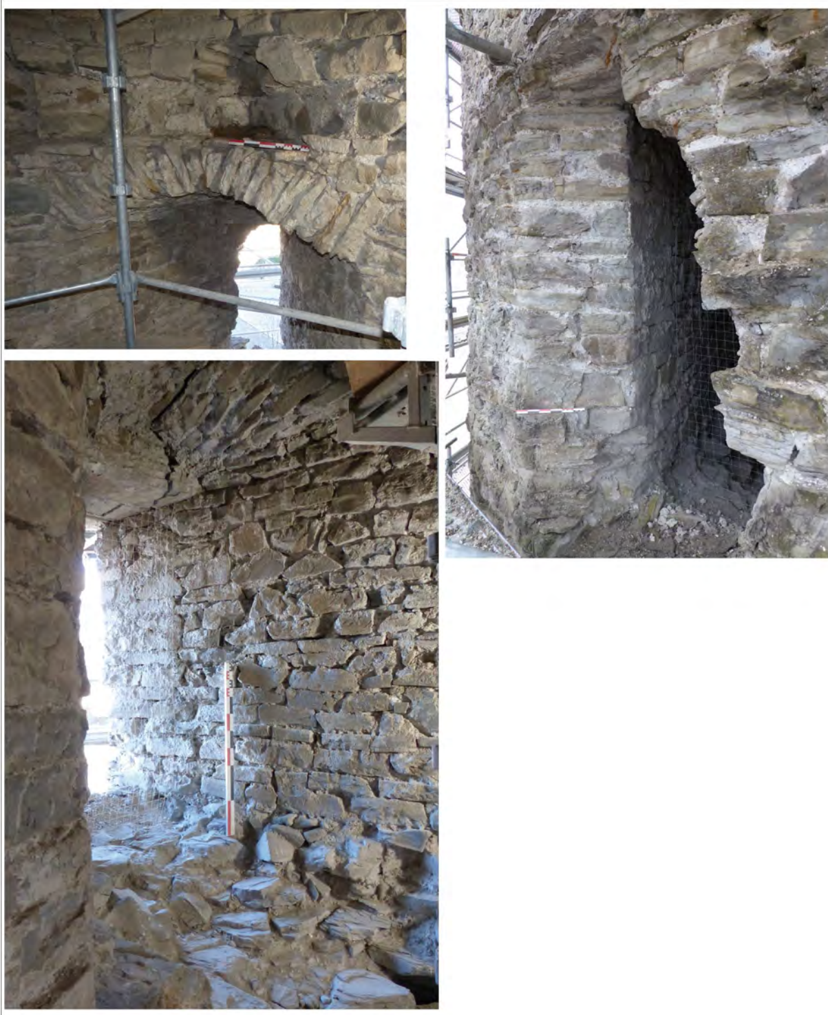
Fig. 28 : Tour nord-est : la voûte (en haut), l'embrasure droite vers le nord (en bas) et l'ébrasement extérieur vers le nord (à droite) de la baie BE 4016. Clichés : S. Bocquet, Inrap
