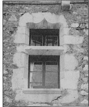
Fenêtre à traverse surmontée d'une accolade (façade Nord)
