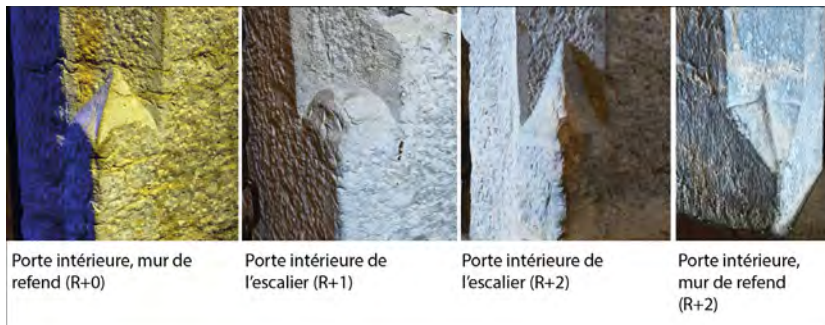
Fig. 26 : Château d'Annecy. Tour et Logis Perrière (ES 6 et 7), congés décoratifs des portes. Doc. : L. D'Agostino et A. Tourasse.
