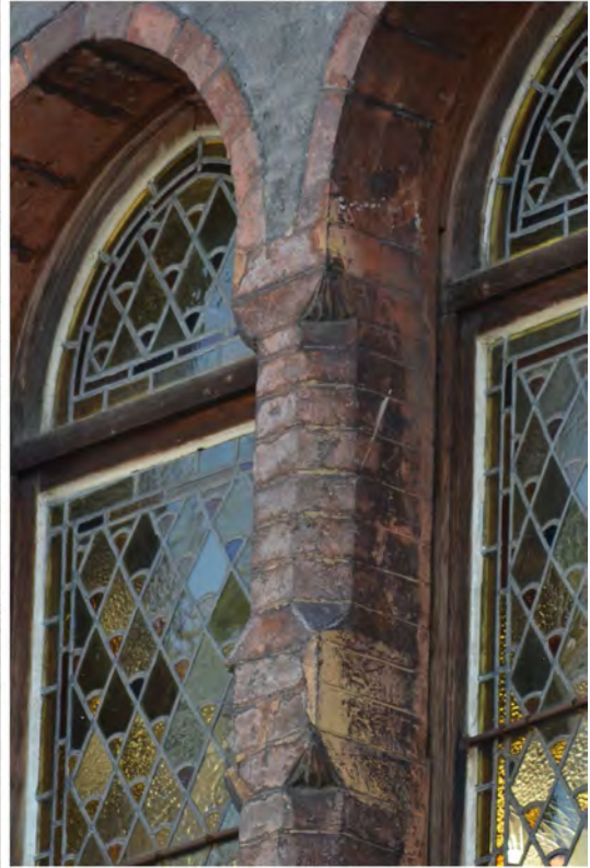
Baie géminée du 1er étage.
