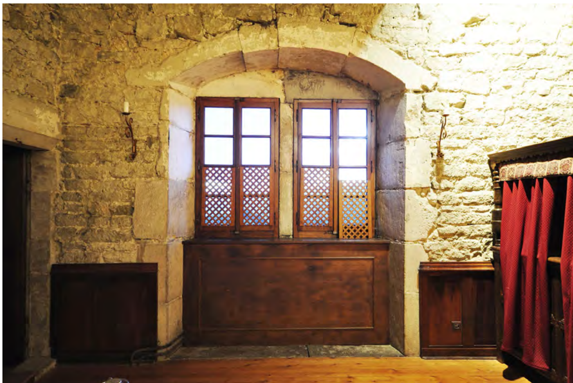
Fig. 29 : Château de Regard, Clermont (74). Baie double à meneau, arrière-voussure et ébrasement interne. Cliché : L. D'Agostino.
