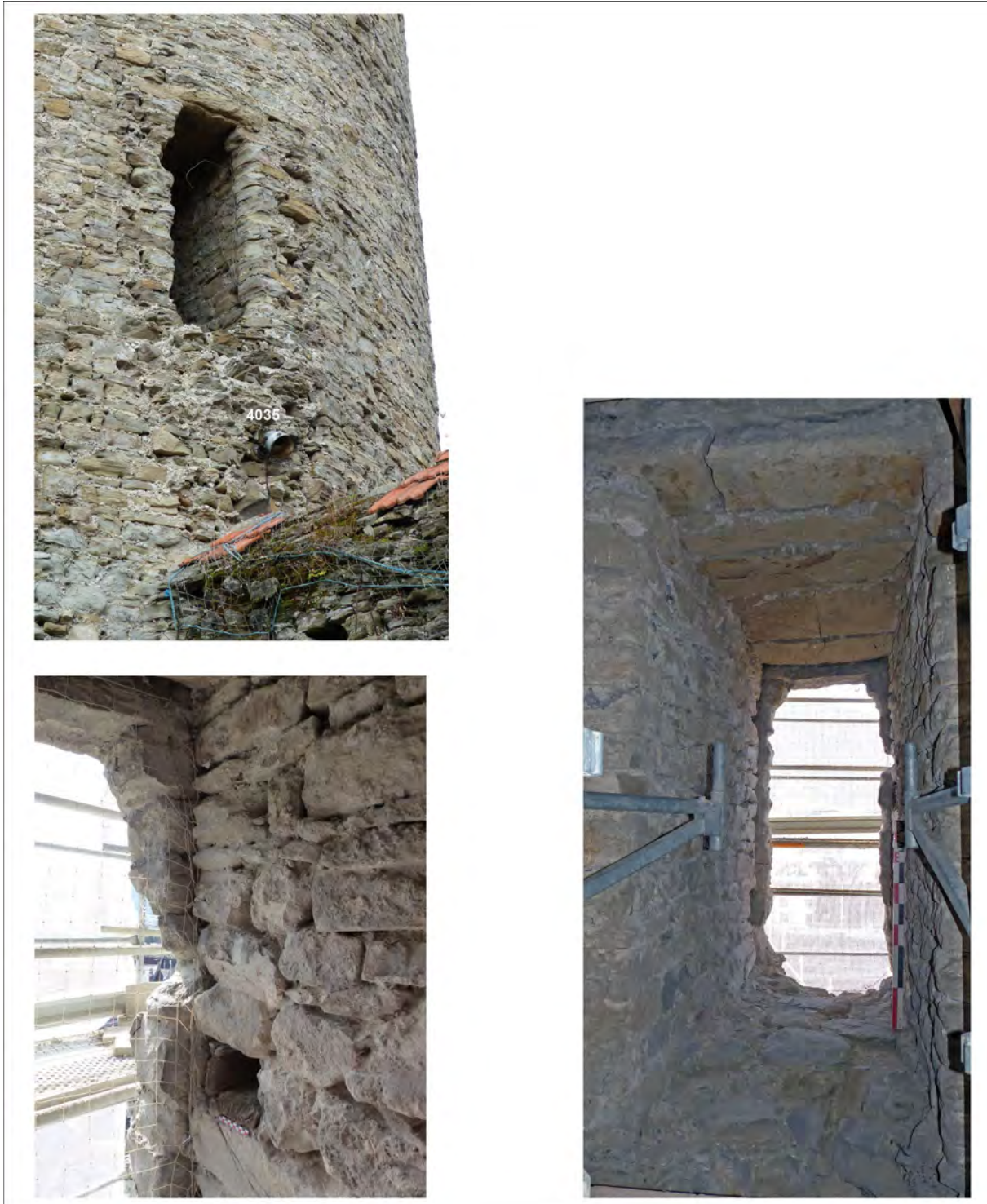
Fig. 34 : Tour nord-est : la porte PR 4015 avant travaux (2017) (en haut) et depuis l'intérieur et vers le sud (en bas à droite), avec détail du trou de barre de l'embrasure droite (en bas à gauche). Clichés : S. Bocquet, Inrap
