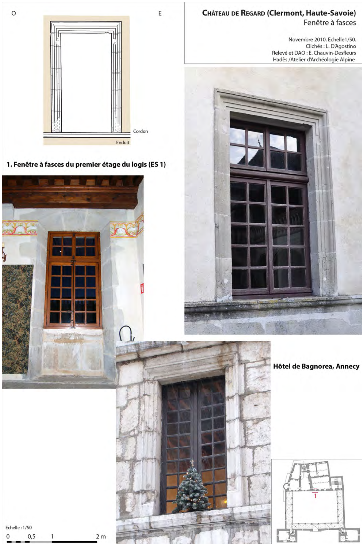
Fig. 24 : Château de Regard, Clermont (74). Relevé d'une fenêtre à fascies. DAO : E. Chauvin-Desfleurs. Clichés : E. Chauvin-Desfleurs, L. D'Agostino.
