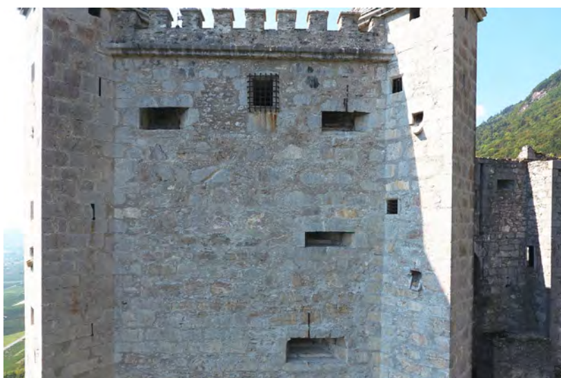
Fig. 27 : Château de Miolans. Les canonnières du mur nord de la tour maîtresse. Cliché : J. Laidebeur
