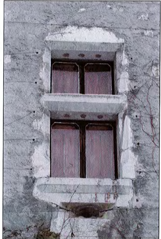
Fenêtre rectangulaire à traverse et sa canotière « à la française » sous tablette (XVI e s.)
