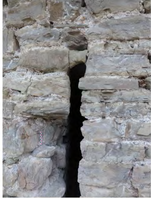
Fig. 26 : Tour nord-est : l'archère BE 4022 depuis l'extérieur (en haut, vue partielle de la fente) et côté intérieur (en bas). Clichés : S. Bocquet, Inrap
