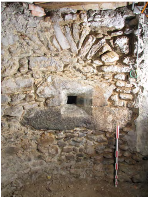
Fig. 37 : Château de Buffavent (Lully, 74). Canonnière de type 1 BE1052 (tour nord), depuis l'intérieur. Cliché : M. Caillet
