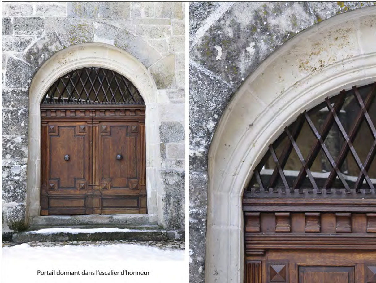
Fig. 25 : Château de Regard, Clermont (74). Porte de l'escalier d'honneur. Clichés : L. D'Agostino.
