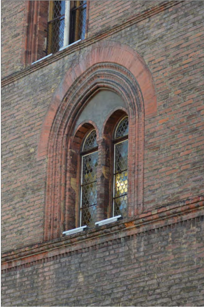
Baie géminée avec colonne en marbre du 2e étage.
