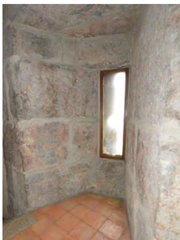
Fig. 30 : Château d'Annecy. Tour et Logis Perrière (ES 6 et 7), archère-canonnaire à évasement central du mur sud (R+1). Doc. : L. D'Agostino.
