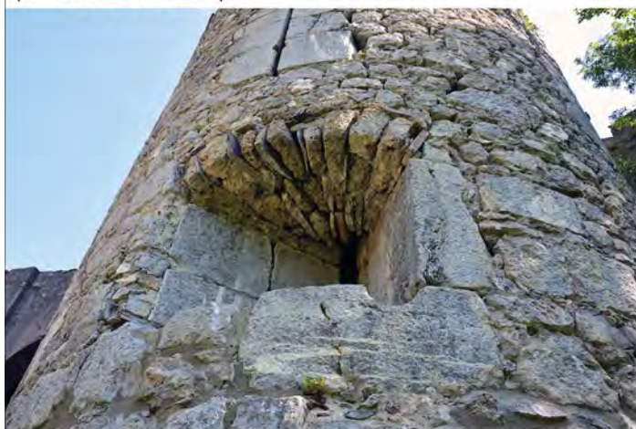
Canonnière (double ?) de la tour sud, éventrée par une canonnière à ébrasement externe de la fin du XVIIe ou du XVIIIe siècle.
