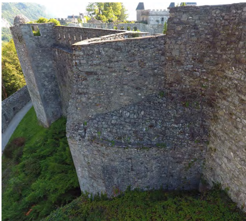
Fig. 25 : Château de Miolans. Petite tour ou moineau en éperon sur le front nord. Cliché : J. Laidebeur
