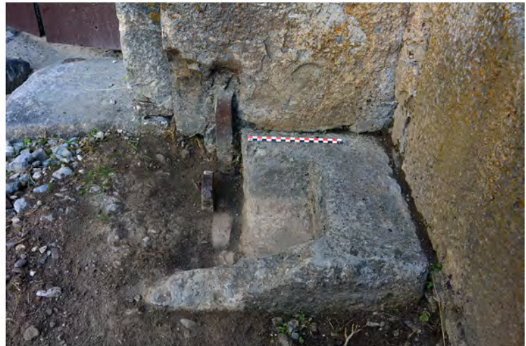
Corbeau à crapaudine sud du pont-levis, recreusé à l'Epoque moderne pour en modifier le système.
