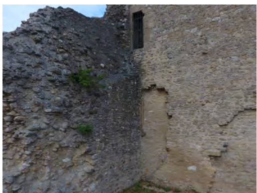
Fig. 22 : Tour de Saint-Denis. RDC, trous d'ancrage du plancher du 1er étage. Cliché : J. Laidebeur.
