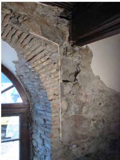
Fig. 10 : Château de Buffavent (Lully, 74). Baie du RDC +1/2r étage ouverte dans le mur sud du logis, en reprise du mur d'origine. Cliché et DAO : M. Caillet, Hadès
