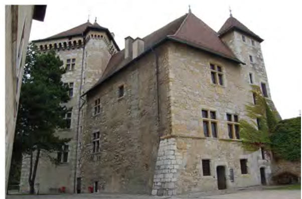
Tour et Logis Perrière. Cliché : E. Chauvin-Desfleurs.
