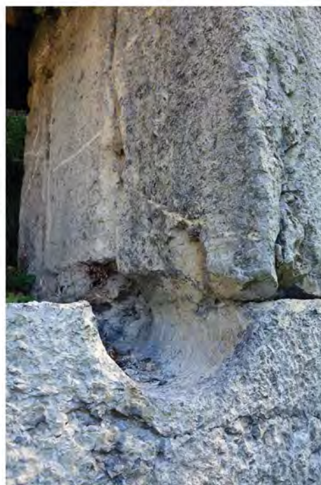
Fig. 49 : Château de Miolans. Détail des canonnières de la tour semi-circulaire du châletet. Clichés : E. Chauvin-Desfleurs
