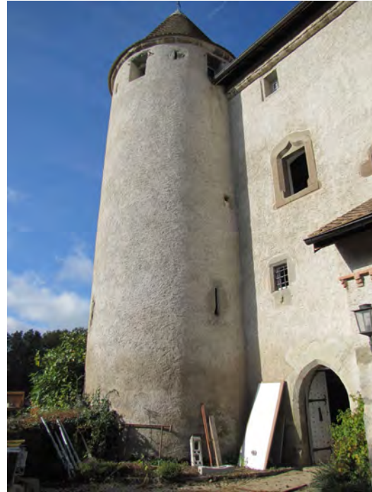
Fig. 7 : Château de Buffavent (Lully, 74). Vue générale de la tour sud-est et de la fenêtre de l'étage contrôlant l'entrée. Cliché. : M. Caillet, Hadès
