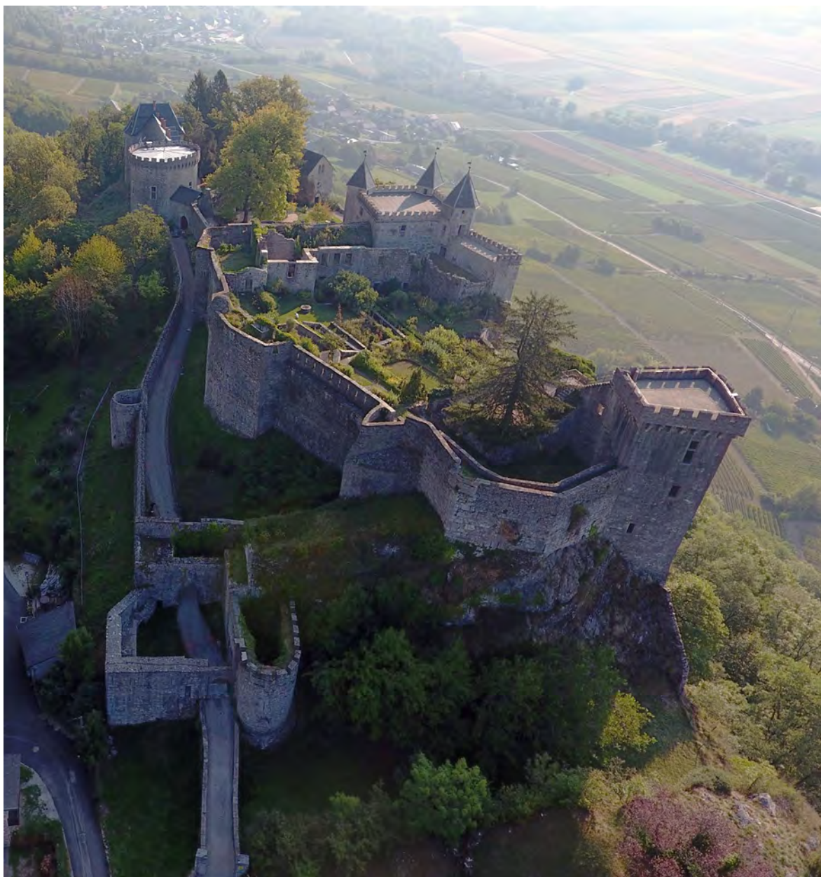
Fig. 16 : Château de Miolans. La rampe d'accès et le châtelet d'entrée. Cliché : J. Laidebeur
