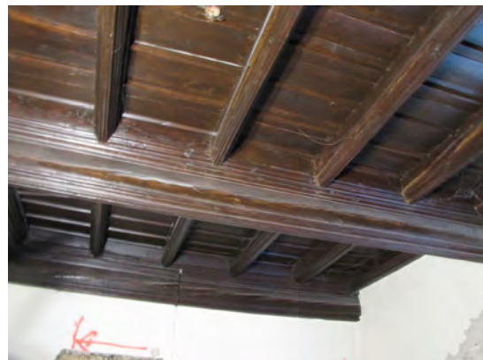
Fig. 11 : Château de Buffavent (Lully, 74). Plafond de l'étage du logis. Cliché. : M. Caillet, Hadès
