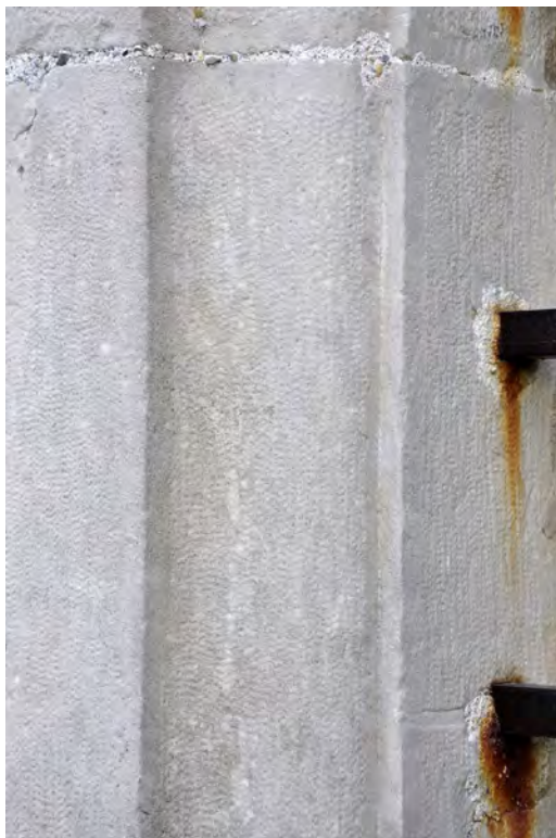
Fig. 27 : Château de Regard, Clermont (74). Baie à doucine, traces de taille à la gradine grain d'orge et arêtes dressées au ciseau. Cliché : L. D'Agostino.
