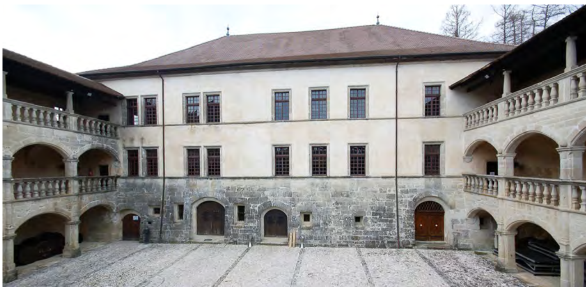
Fig. 7 : Château de Regard, Clermont (74). Le logis et la cour à péristyle. Cliché : L. D'Agostino.
