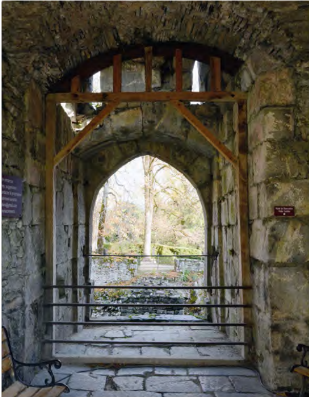
Intérieur de la porte, avec voûte du XVIIIe siècle qui a bouché la partie haute.
