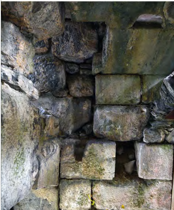
Trou d'engagement de la crapaudine de l'axe des flèches, bouché.
