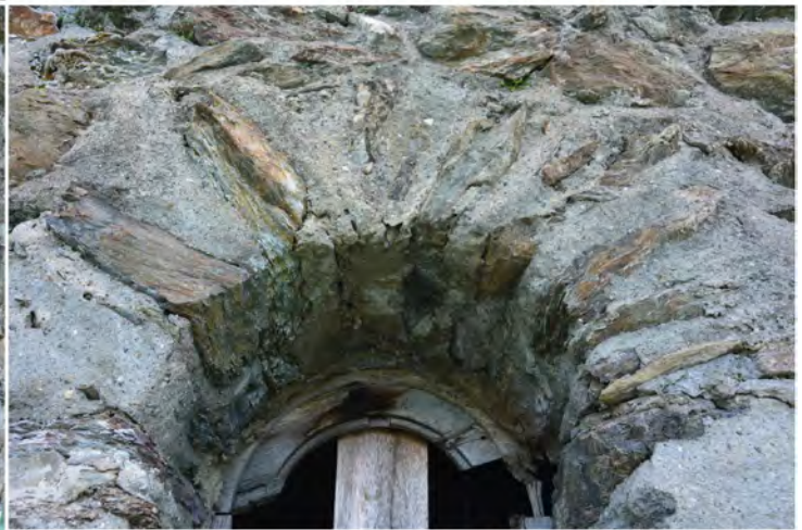
Piédroits et claveaux en schiste de la baie FEN 11 (M 2). Restauration des joints au ciment gris (UC 1005).
