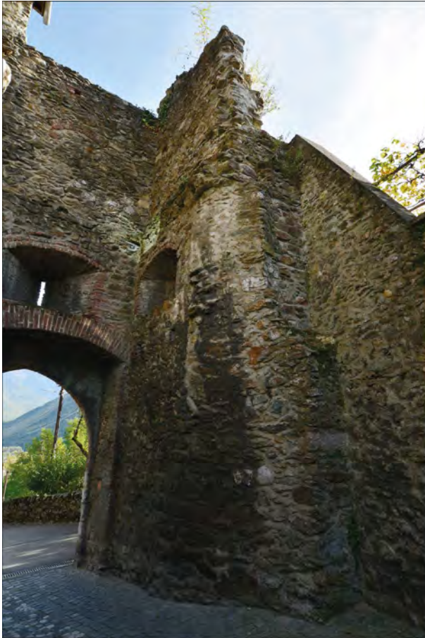
Consolidation de l'arrachement.
