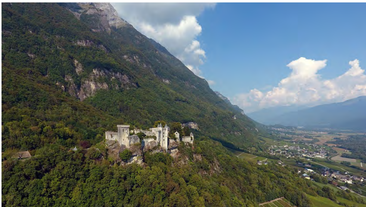
Fig. 3 : Château de Miolans. Le site de Miolans, au pied de l'Arclusaz. Cliché : J. Laidebeur
