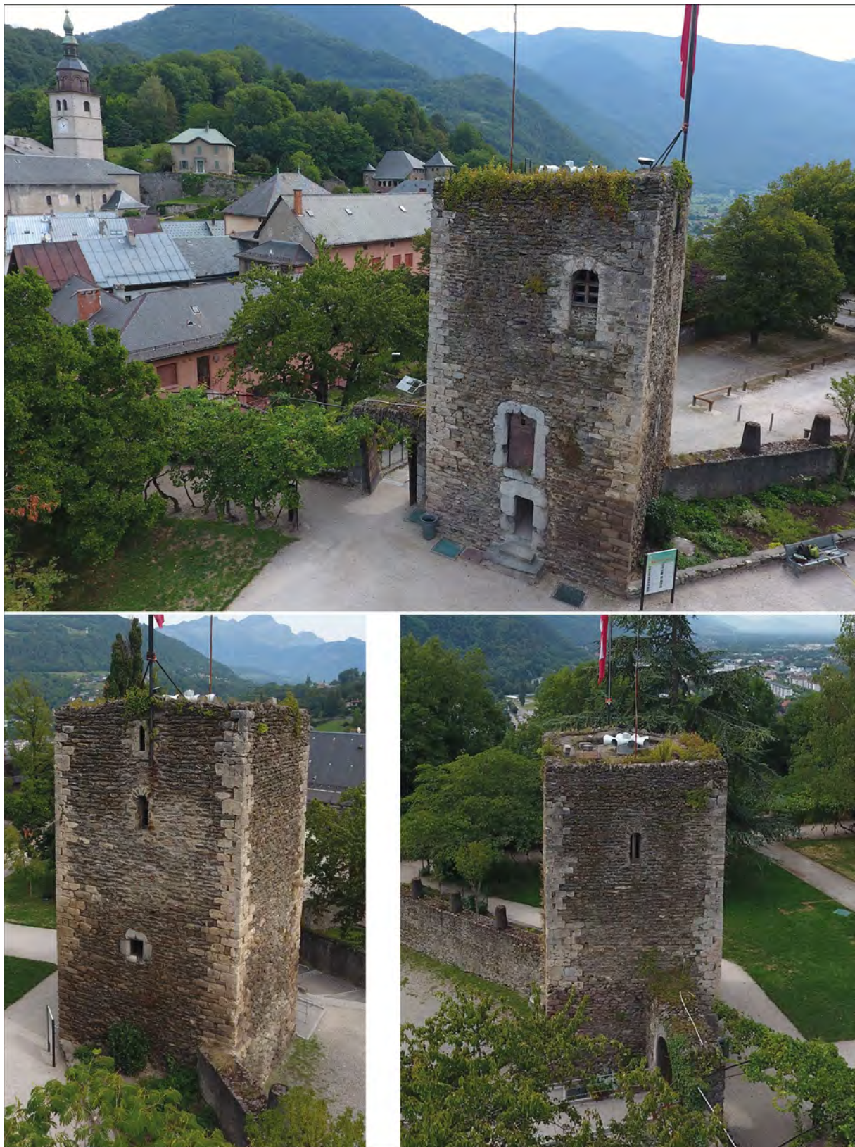
Fig. 18 : Tour Sarrasine. Vues d'ensemble de la tour en 2019. Clichés : J. Laidebeur
