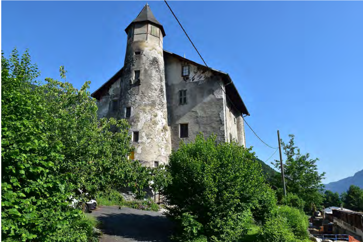
Fig. 5 : Maison forte de La Frasse (Sallanches, 74). Façade sud du bâtiment. Cliché : L. Benoit.
