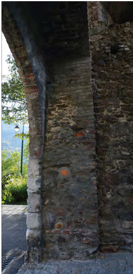
Piédroit et tableau sud-ouest.
