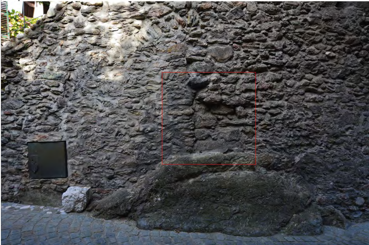
Fig. 11 : Porte Tarine. Insertion de la tour porte dans un bâti existant. Clichés : E. Chauvin-Desfleurs.
