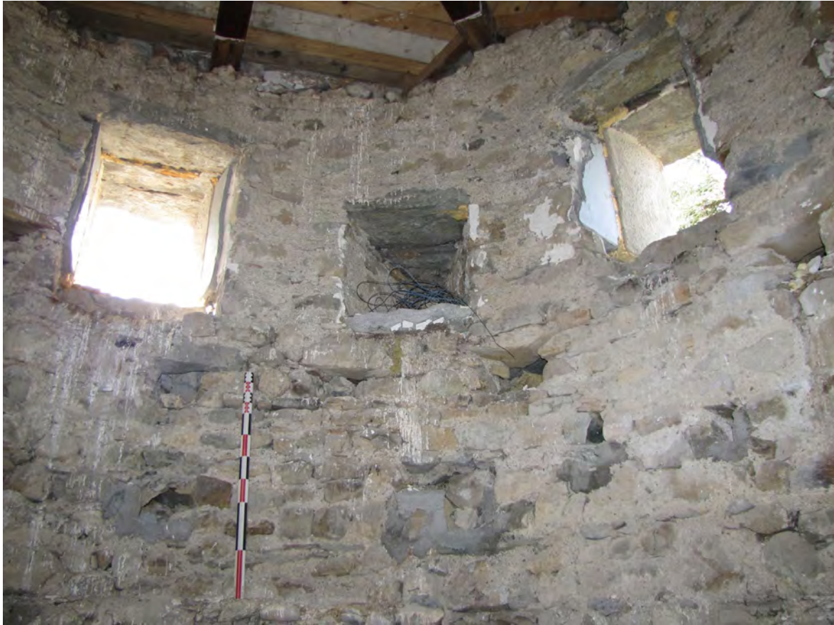
Fig. 46 : Château de Buffavent (Lully, 74). Baie et ouvertures de tir du dernier niveau de la tour nord. Cliché : M. Caillet
