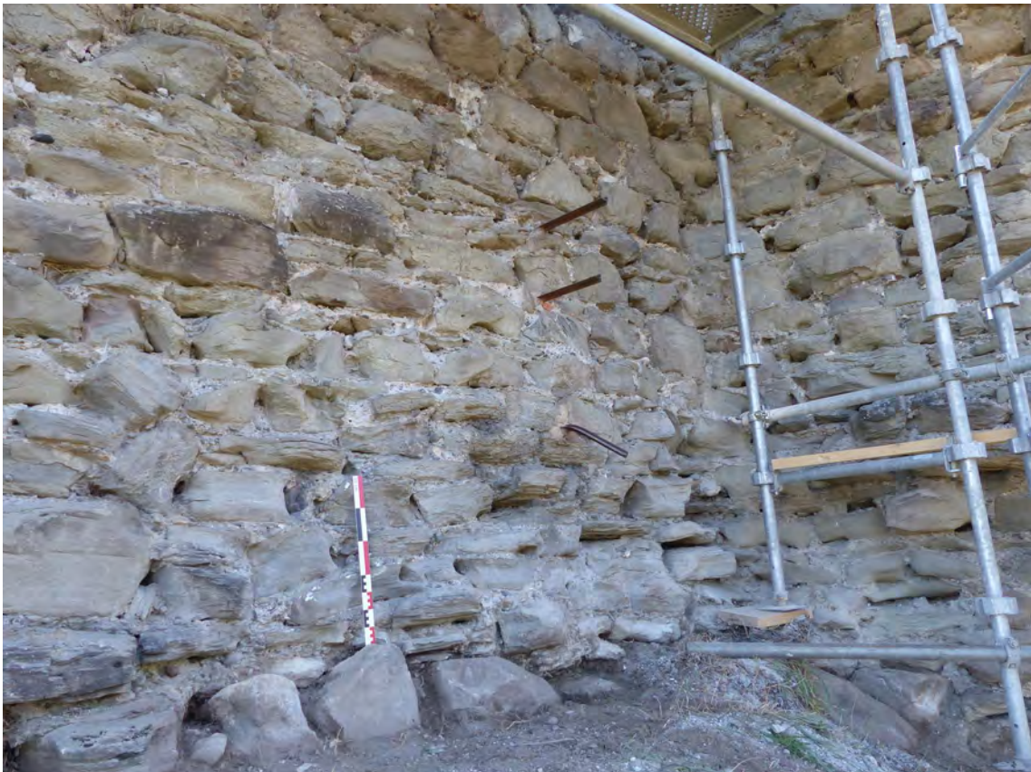
Fig. 11 : Vue de la partie inférieure la courtine sud au contact de la tour sud-est, vers l'est. Cliché : S. Bocquet, Inrap
