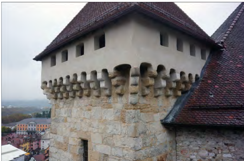
Mâchicoulis et combles défensifs de la tour Saint-Pierre. Cliché : P. Fleury et L. D'Agostino
