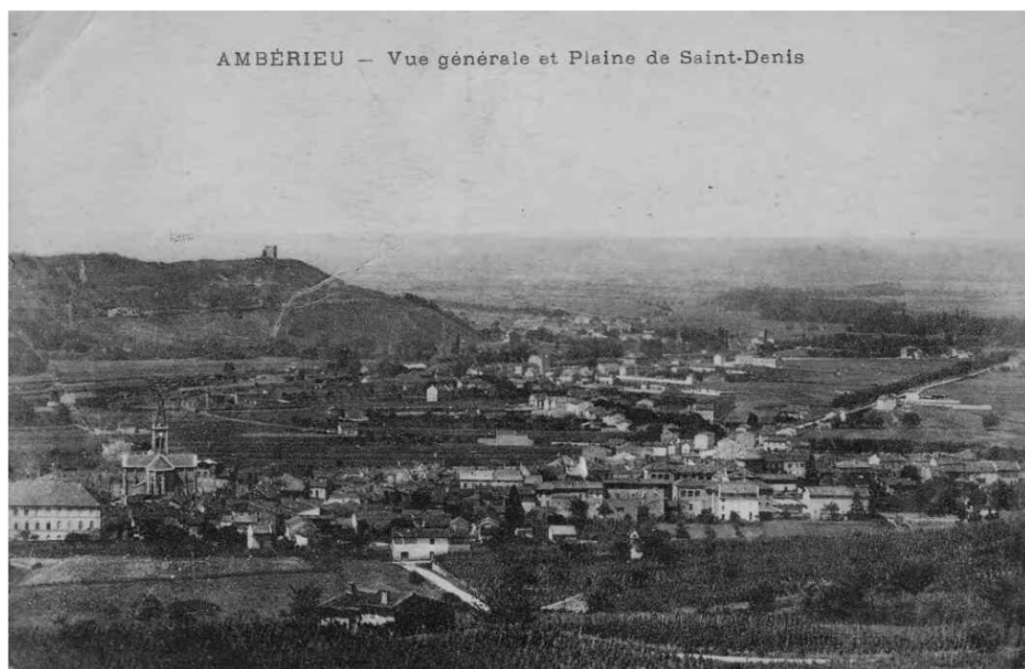
Fig. 16 : Tour de Saint-Denis. Le site au début du XXe siècle vu depuis l'est. Doc. : AD Ain, 5 Fi 4-3 .
