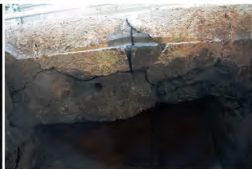
Ebrasement interne recouvert d'un enduit lissé rose à rouge (enduit de greya).
