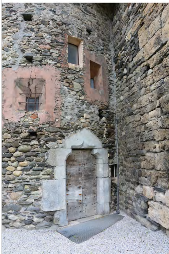
Fig. 27 : Tour Sarrasine. L'utilisation de l'enduit de greya et du mortier de tuileau à la Renaissance. Clichés : C. Randon, E. Chauvin-Desfleurs, L. D'Agostino.
