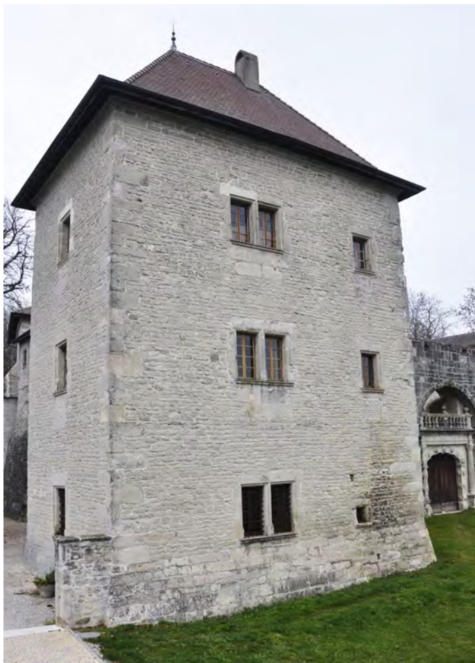
Fig. 14 : Château de Regard, Clermont (74). Le pavillon sud-ouest (ES 5), façade sud. Cliché : E. Chauvin-Desfleurs.
