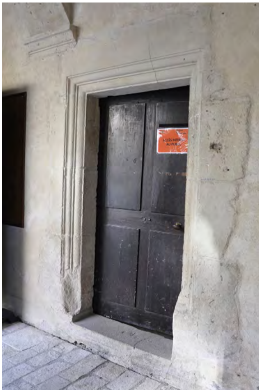
Fig. 31 : Château de Regard, Clermont (74). Porte à fascies au rez-de-chaussée du pavillon occidental. Cliché : E. Chauvin-Desfleurs.
