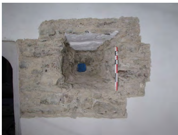
Fig. 43 : Château de Buffavent (Lully, 74). Canonnière de type 2 BE3028 (sud, 1er étage), depuis l'intérieur. Cliché : M. Caillet
