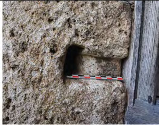
Trou d'ancrage lié à la modification du système de fermeture.
