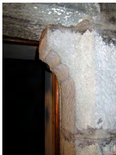
Fig. 29 : Château de Buffavent (Lully, 74). Porte PR1043, détail de la moulure du dernier bloc du piedroit est. Cliché : M. Caillet
