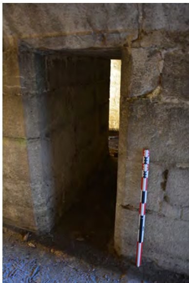
Fig. 38 : Château de Chambéry. Passage étroit aménagé entre deux chambres de tir de la salle d'artillerie. Cliché : L. D'Agostino.
