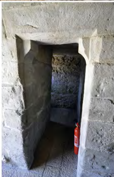
Porte à coussinets donnant sur le couloir des latrines.
