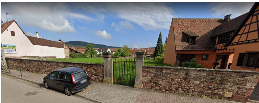
Fig.18 Vue du mur de clôture du cimetière B. Dottori, Inrap
