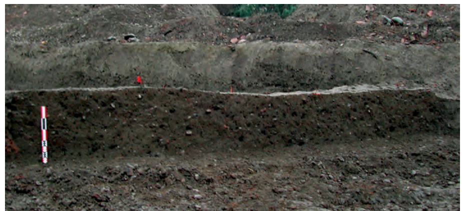
► Fig. 18 : Coupe longitudinale dans le mur MR 5 : aucun litage ne permet de distinguer les traces d'éventuelles banchées lors de sa construction (cliché : Jérôme Briand, Inrap).
