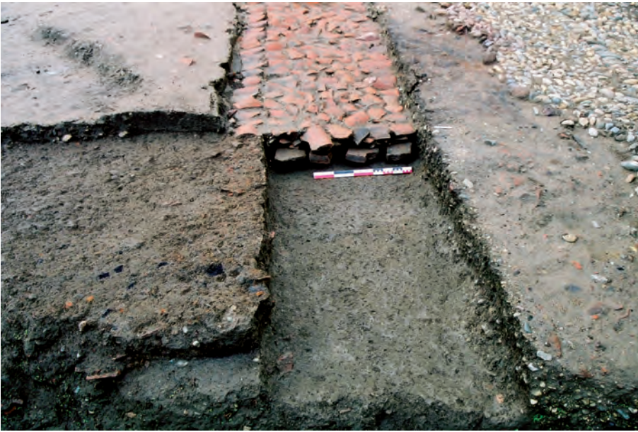
◄ Fig. 34 : Vue partielle de la structure ST 1091 en cours de démontage (cliché : Jérôme Briand, Inrap).
