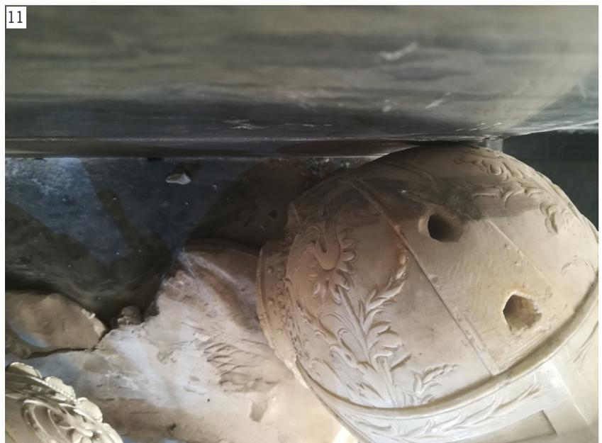
**Fig. 12** - Une fissure sous le genou droit du gisant est visible depuis l'arrière du sujet.
