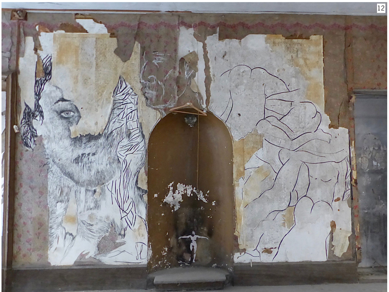
Fig. 11 - Romans-sur-Isère, 26, hôtel de Loulle. Escalier monumental, vue du palier intermédiaire entre R+1 et R+2, vue vers l'ouest. (Cliché : Ch. Delomier, Inrap)
