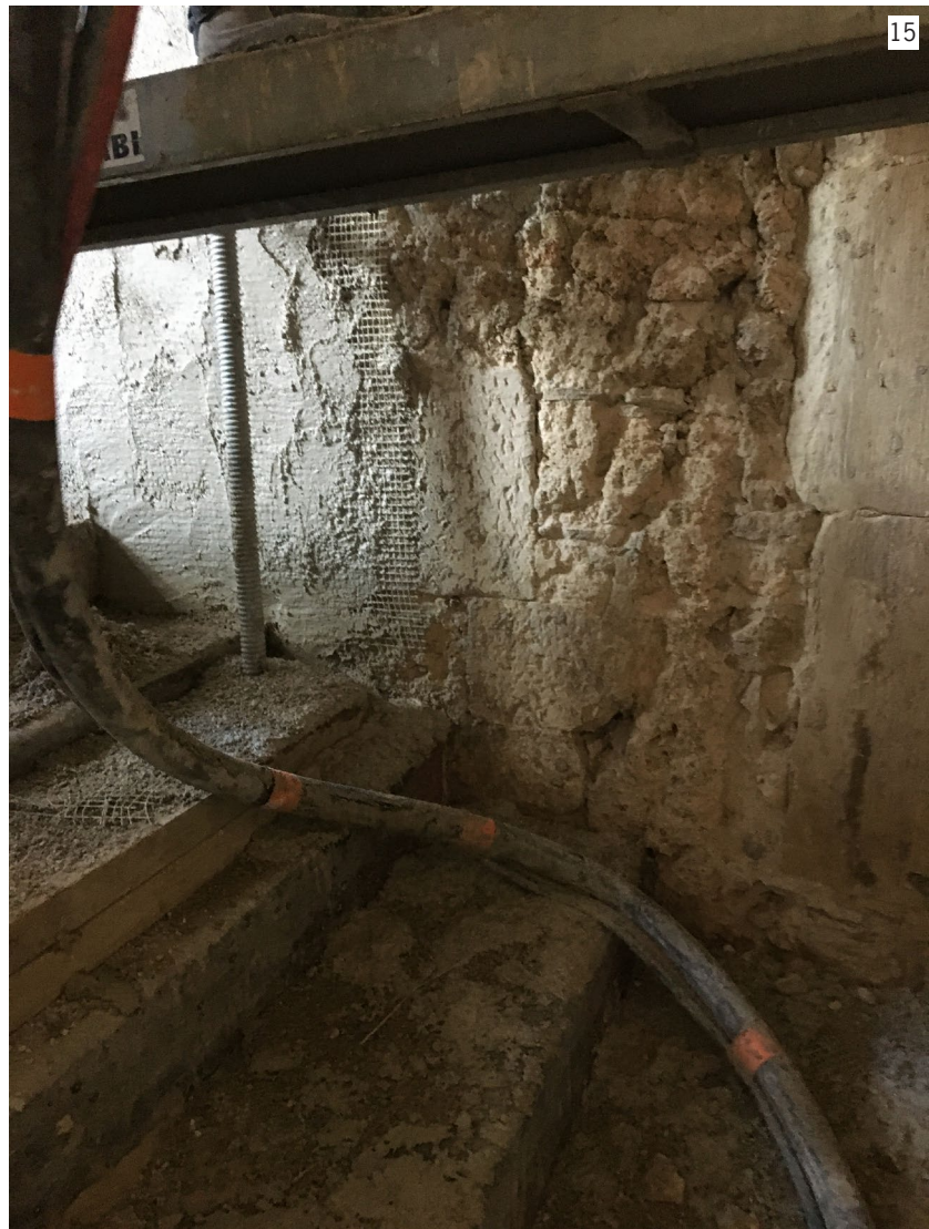
Fig. 15 - Romans-sur-Isère, hôtel de Loulle. R+2, pose de gobetis sur le mur médiéval longitudinal (M1), piqueté et enduit sans préavis. (Cliché : Ch. Delomier, Inrap)
