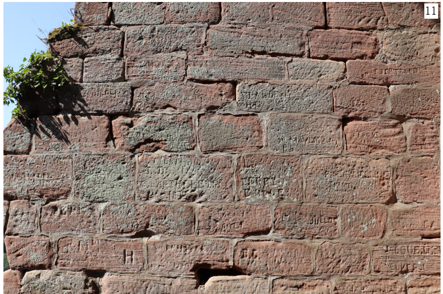
Fig. 11 - Les graffitis sont révélés par la lumière naturelle rasante sur une portion du mur intérieur ouest de la tour-donjon du château de Pierre-Percée (54). (Antoine Lacaille, Inrap)
