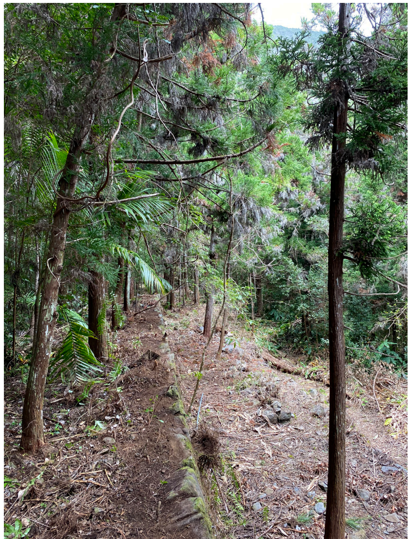
Fig. 12 - Débroussaillage des murs de terrasses.
