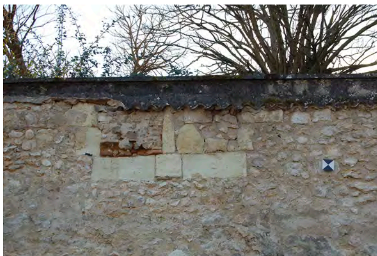
Fig. 52. Fenêtre Renaissance au-dessus des corbeaux dans le grand mur de soutènement (fig. 50 : m) (D. Josset / Inrap).
