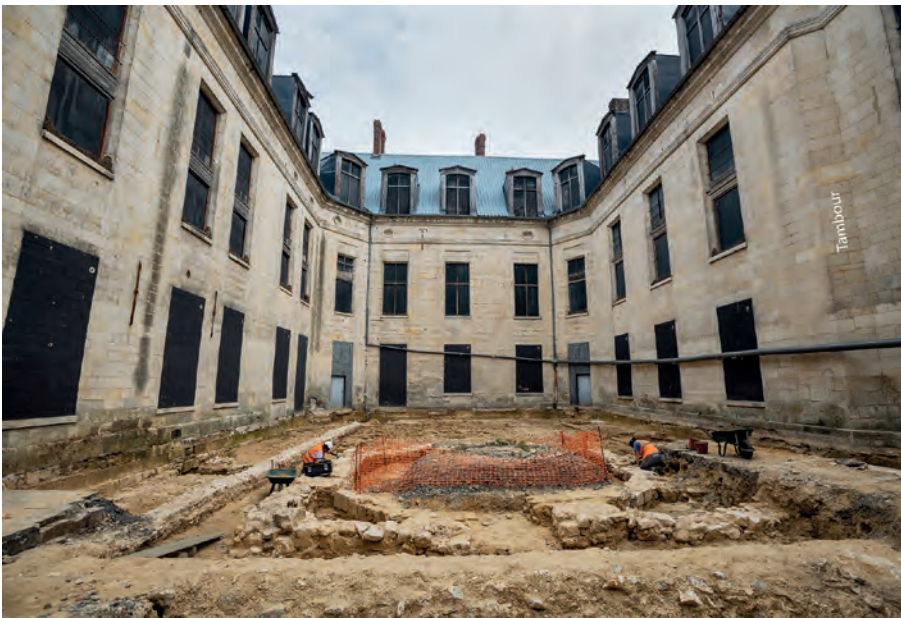
Fig. 76. Vue générale de la cour du jeu de paume et de ses façades pendant la fouille depuis le sud (D. Gliksman).
