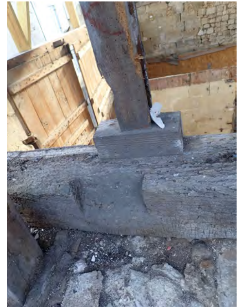
Fig. 235. (à gauche). Trou de cheville et mortaise traversante (indiqués par les flèches blanches) sur le poteau nord de la ferme F21 (C. Perrault / CEDRE).
