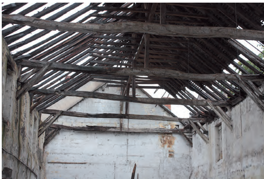
Fig. 229. (ci-contre). Vue de la charpente du théâtre de la Comédie à Angers, juste avant sa démolition en septembre 2008 (J.-Y. Hunot / conservation départementale du patrimoine de Maine-et-Loire).
