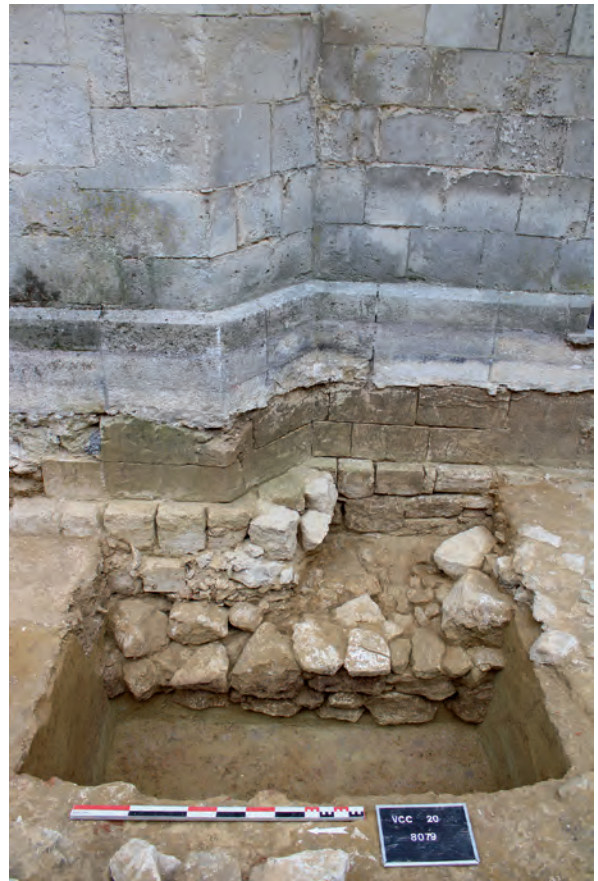
Fig. 79. Vue générale du sondage réalisé au pied du tambour depuis l'ouest. La fondation de la façade marquée par le décrochement oblique du tambour repose sur la maçonnerie médiévale (MR8079) (M. Raymond / Inrap).
