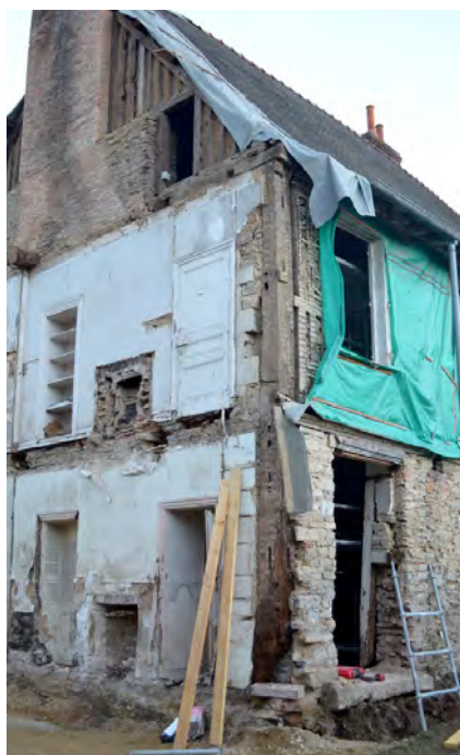
Fig. 172. Le poteau cornier de l'angle nord-ouest (E. Cadiou / Inrap).
