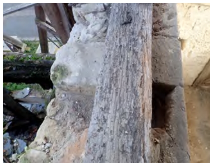
Fig. 234. Réserve creusée au sommet du mur gouttereau nord entre les fermes F3 et F9 (C. Perrault / CEDRE).
