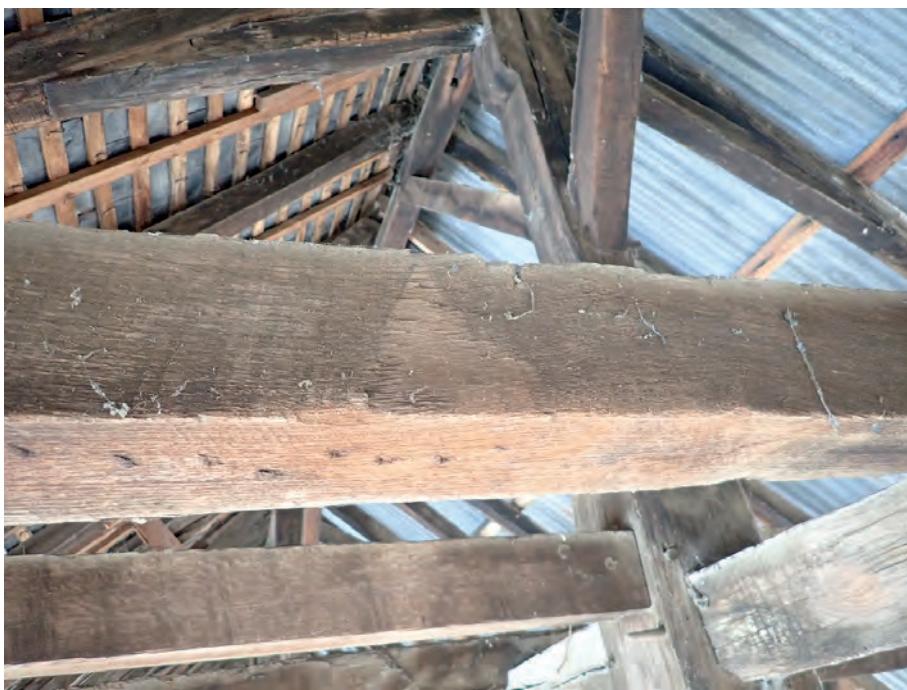
Fig. 233. Triangle d'arrachement des fibres à la jonction des traits de sciage manuel sur une face d'un entrail retroussé (C. Perrault / CEDRE).
