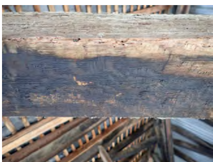
Fig. 232. (ci-dessous). Traces de carbonisation superficielle sur la face inférieure d'un entrait retroussé (C. Perrault / CEDRE).
