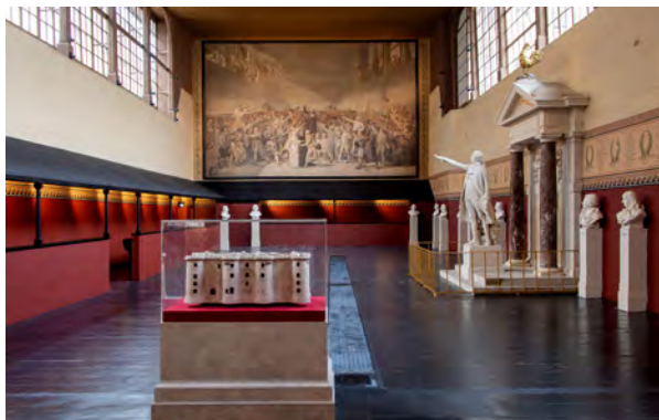
Fig. 192. Vue intérieure du jeu de paume avant travaux (mars 2022) (D. Saulnier / EPV). Dans les hauteurs de la salle, les poteaux sont en avant des verrières à l'ouest (à gauche), alors qu'à l'est (à droite) les verrières sont incluses entre les poteaux. Dans les quatre angles de la salle, on voit les maçonneries trapézoïdales surmontant la partie basse des murs. Les côtés inclinés des trapèzes supportaient des emmarchements.
