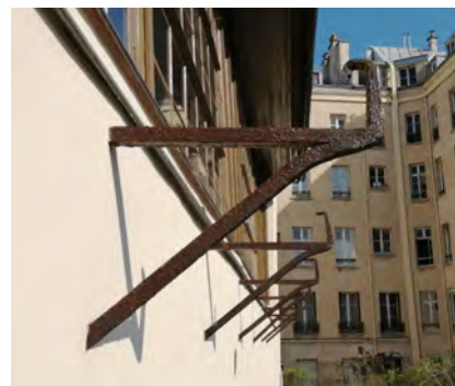
Fig. 195. Jeu de paume du Serment à Versailles : les consoles pour les galeries hautes du public (J.-Y. Dufour / Inrap).
