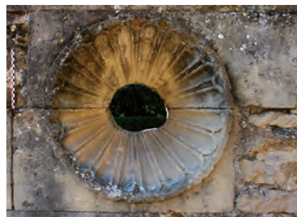
Fig. 42. Vue de l'oculus ornant la partie sud-ouest et permettant d'éclairer la galerie ouest (G. Roquefort).
