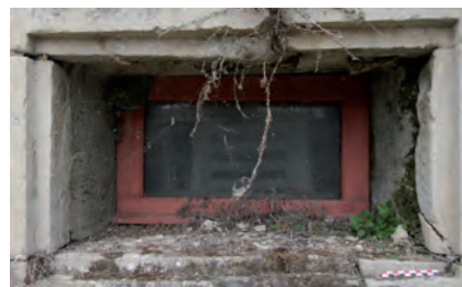
Fig. 43. Vue de la fenêtre de la remise agricole (XVIII e s.), considérée à tort comme une lune (G. Roquefort).
