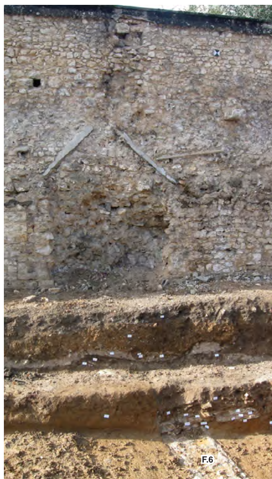
Fig. 72. Vue vers le sud-ouest du grand mur du soutènement du jardin bas dans lequel sont fixés les corbeaux ; le sondage 5 est au premier plan (D. Josset / Inrap).
