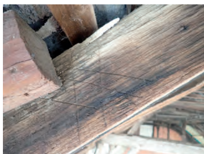
Fig. 230. (ci-dessous). Jeu de paume du Biziou à Chinon : marque « 50 » résultant de plusieurs fusions de X et contremarque ajoutée au franc sur la face orientale du chevron sud de la ferme F15 (C. Perrault / CEDRE).
