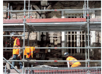
Fig. 164. L'étude de bâti en façade (E. Cadiou / Inrap).
