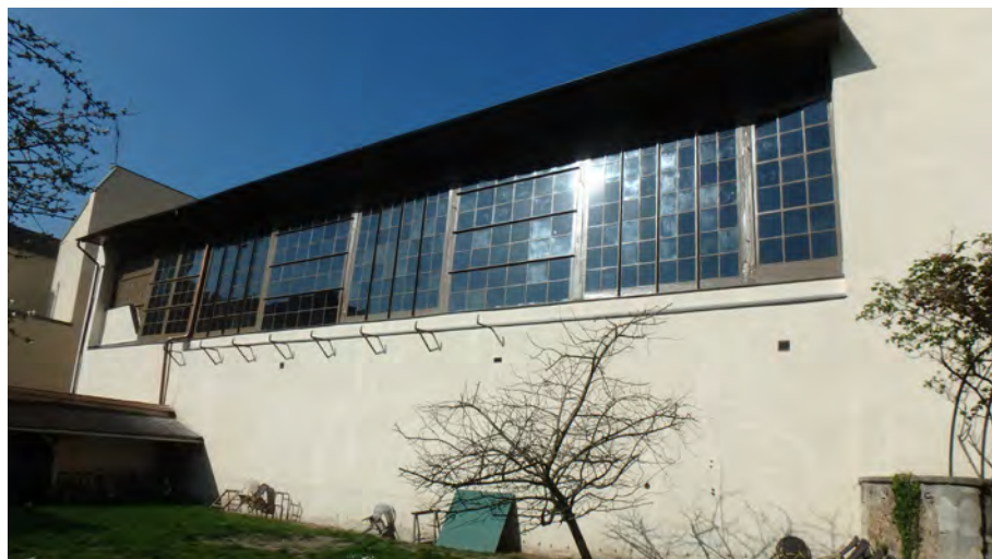
Fig. 195. Jeu de paume du Serment à Versailles : les consoles pour les galeries hautes du public (J.-Y. Dufour / Inrap).
