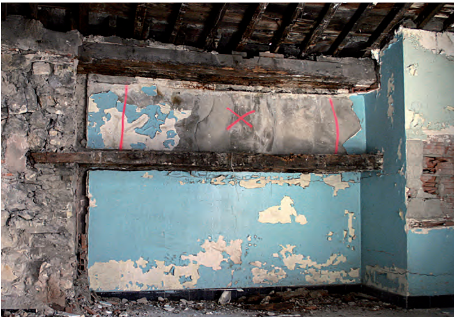
Fig. 184. La moitié supérieure de la seule fenêtre conservée, dans l'angle nord-est de la salle (B. Sillano / Inrap).
