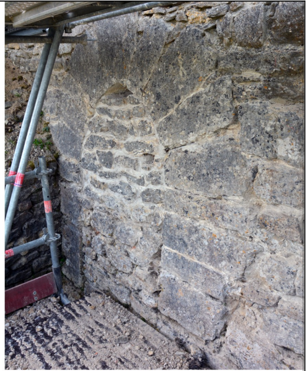
Insertion de la poterne dans le parement environnant.
