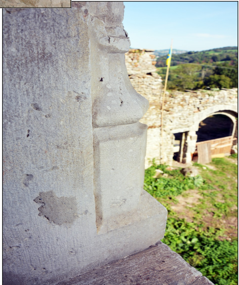
Figure 171 : Mionnaz (74). Détail de la mouluration de la fenêtre croisée du 1 er étage. Cliché : E. Chauvin-Desfleurs.
