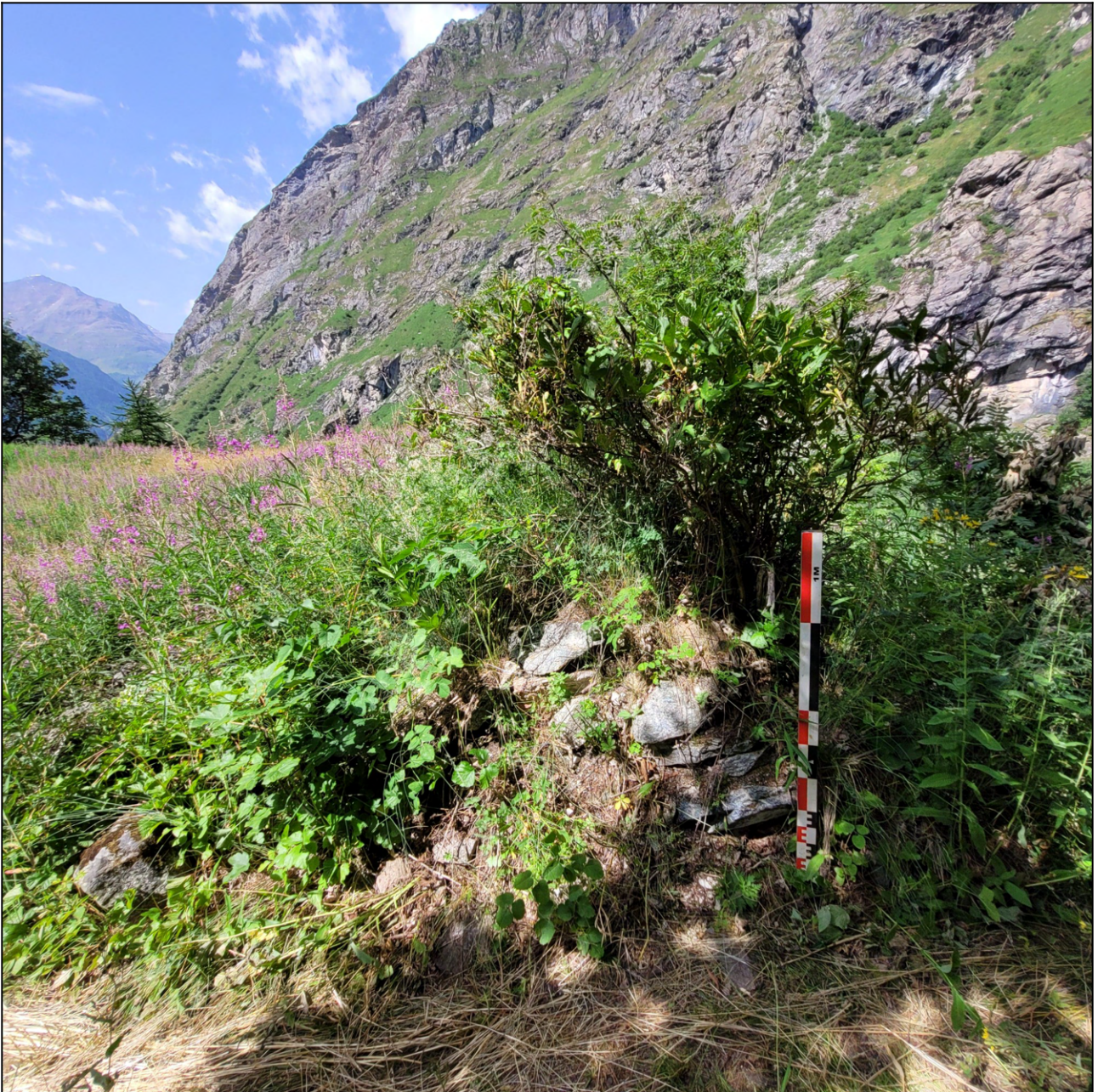
Figure 94 : Rocher du Château : coupe de l'enceinte par un accès agricole (Cliché D. Billoin).
