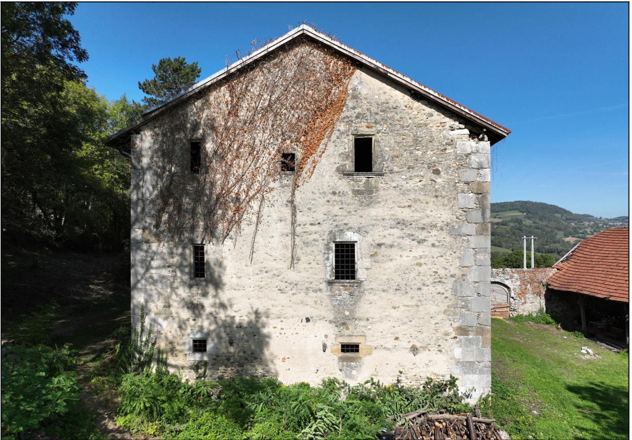
Figure 133 : Mionnaz (74). Vue de la façade sud. Cliché : L. Benoit.
