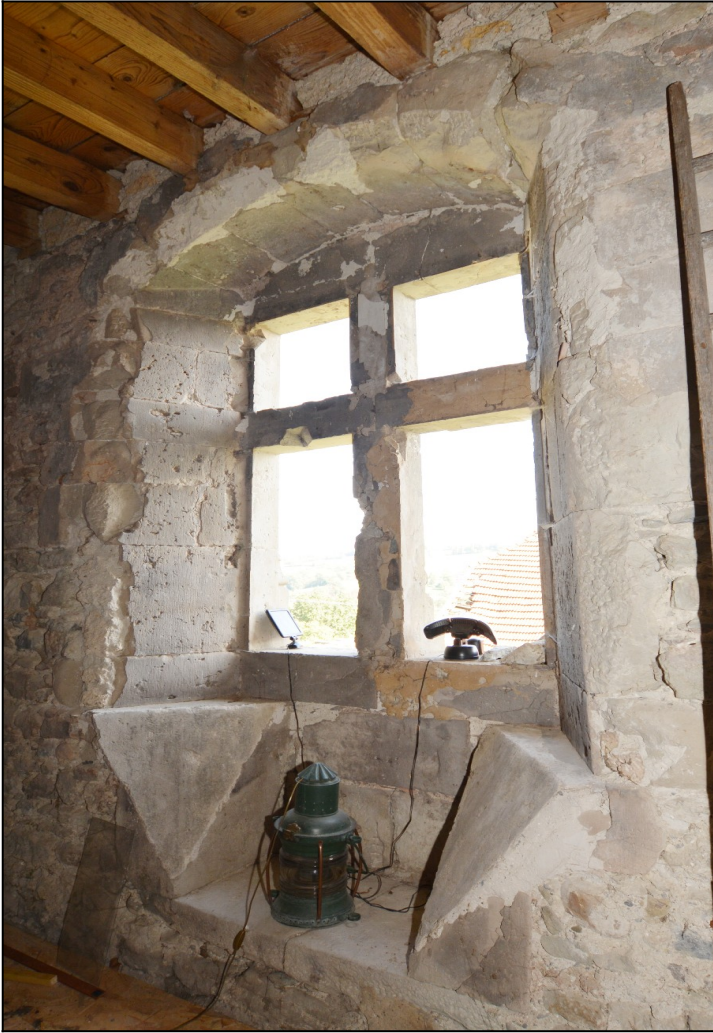
Figure 170 : Mionnaz (74). Ebrasement interne de la fenêtre croisée du 1 er étage. Cliché : E. Chauvin-Desfleurs.
