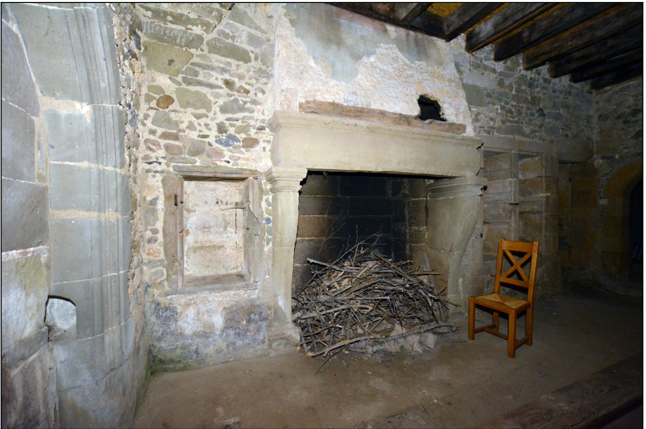
Figure 166 : Mionnaz (74). Cuisine, cheminée médiévale bouchée et remplacée par une cheminée du XVIIe s. Cliché : E. Chauvin-Desfleurs.
