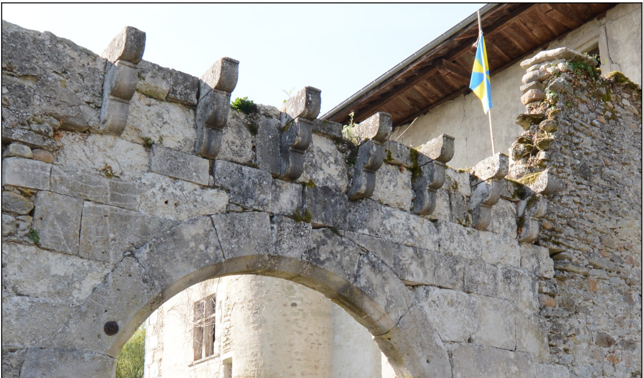
Figure 175 : Mionnaz (74). Consoles des mâchicoulis de la bretèche du portail. Cliché : E. Chauvin-Desfleurs.
