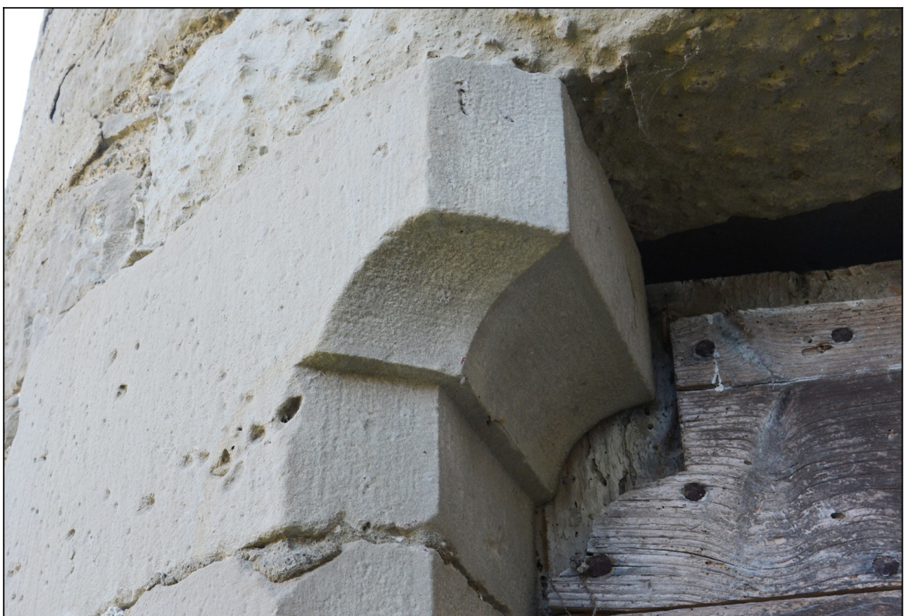
Figure 158 : Mionnaz (74). Tour d'escalier, détail d'un coussinet de la porte d'entrée. Cliché : E. Chauvin-Desfleurs.
