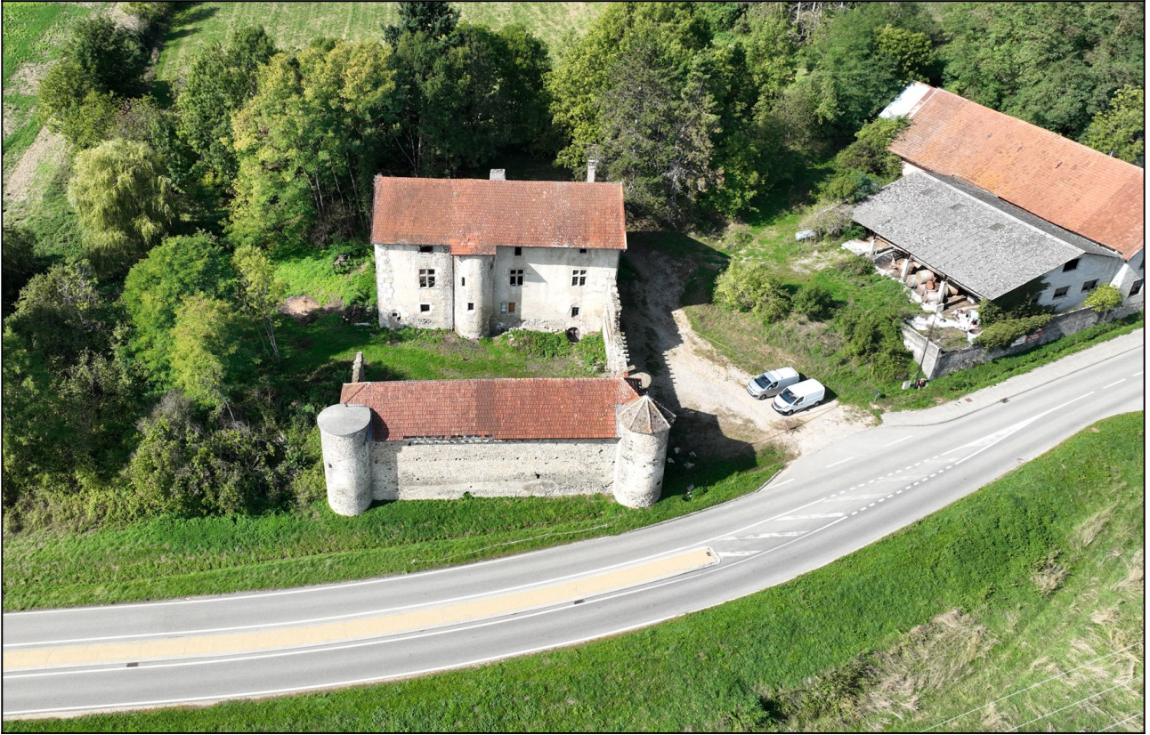
Figure 127 : Mionnaz (74). Vue générale de la maison forte depuis l'est. Cliché : L. Benoit.
