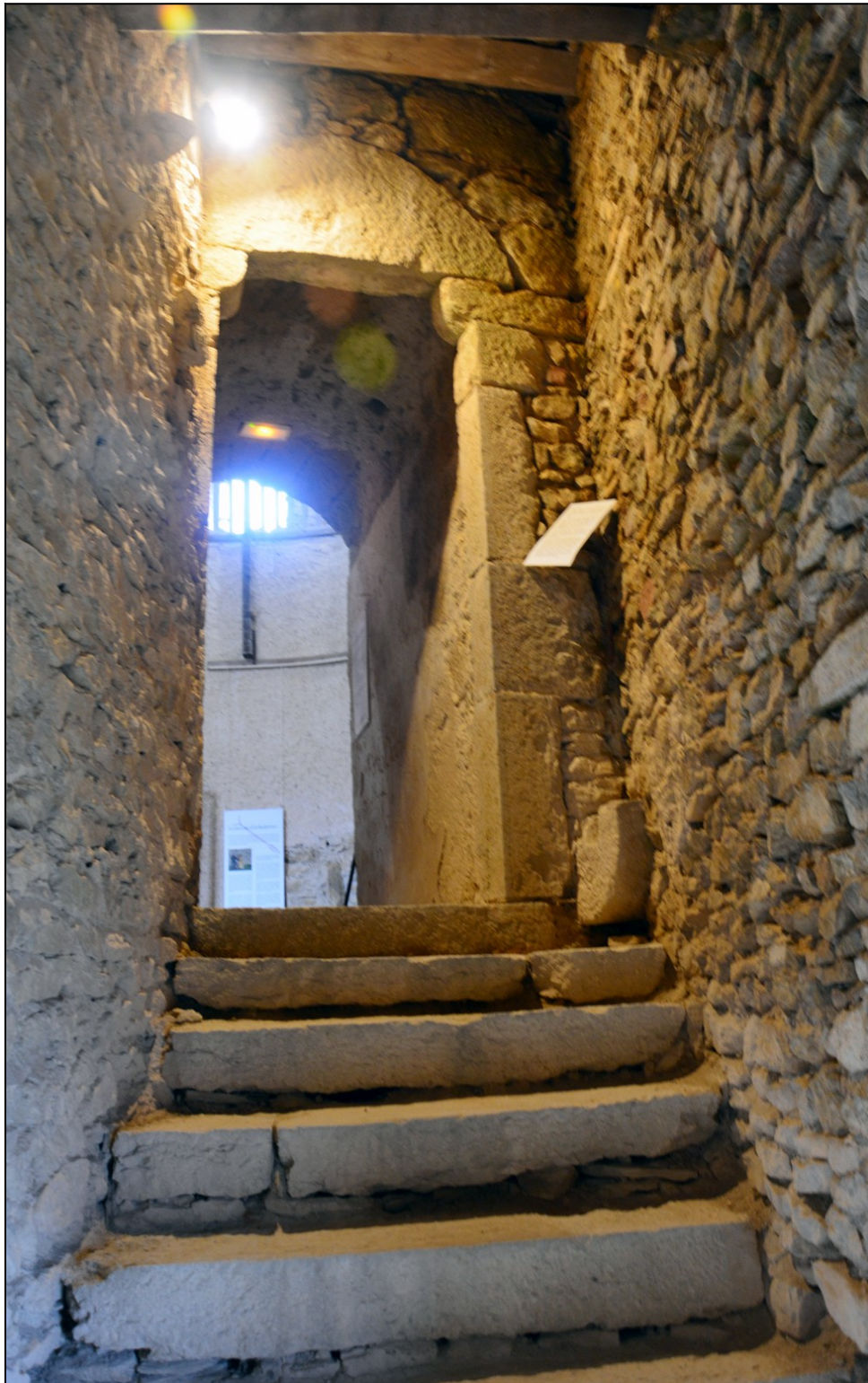
Figure 115 : Château des Allymes. Tour ronde (ES 4), porte de communication entre le 2e étage de la tour et la courtine est. Cliché : L. D'Agostino
