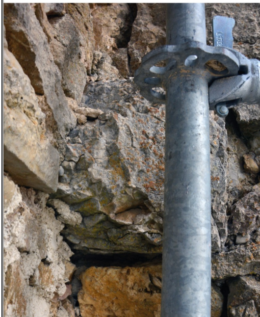
Corbeau bûché sur le parement extérieur, masqué par le parapet actuel
