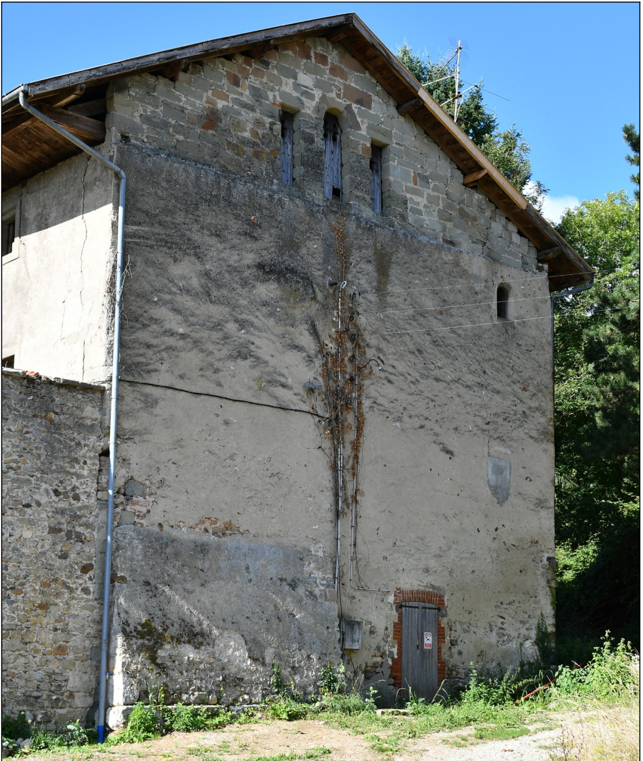
Figure 131 : Mionnaz (74). Vue de la façade nord. Cliché : L. Benoit.
