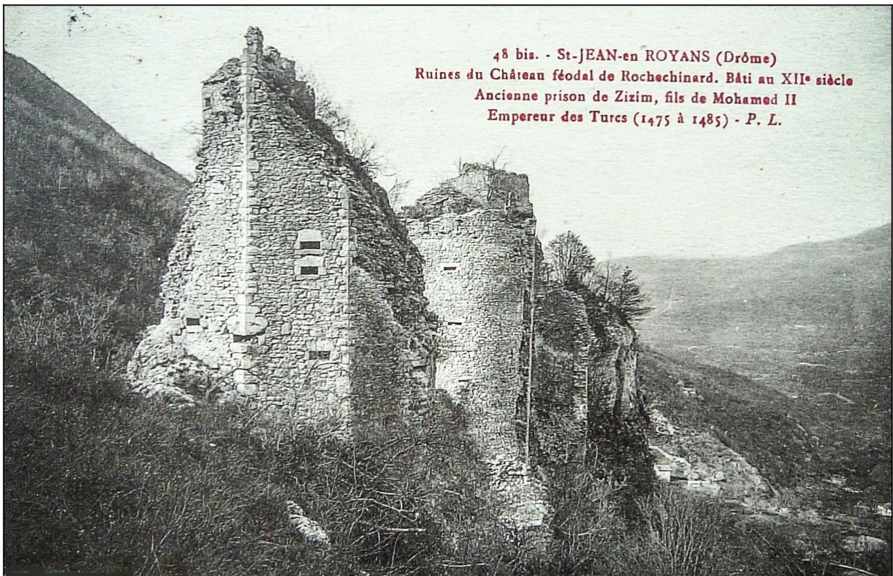
Figure 29 : Château de Rochechinard (Drôme), tours d'artillerie.
