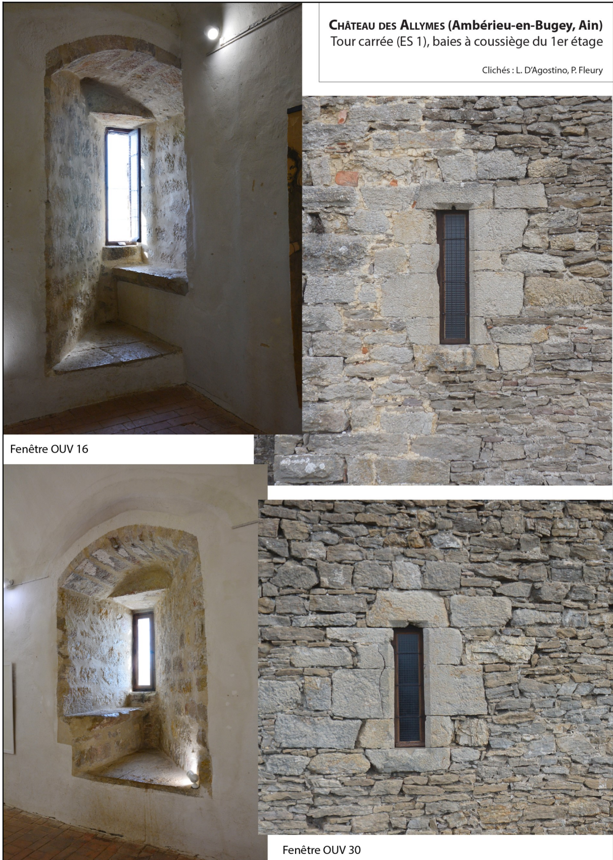
Figure 118 : Château des Allymes. Tour carrée (ES 1), baies à coussiège du 1er étage. Doc. : E. Chauvin-Desfleurs, L. D'Agostino
