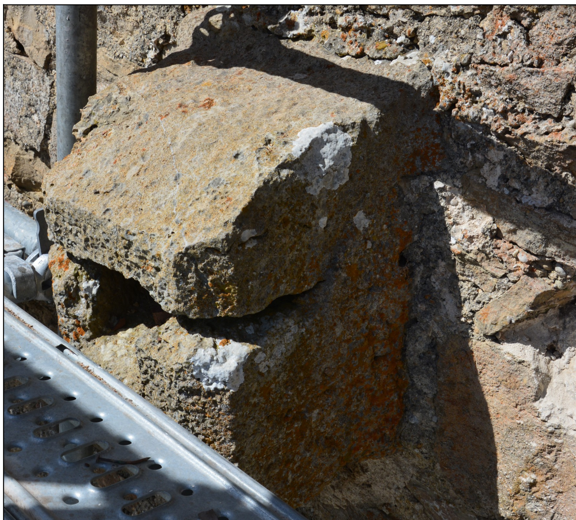
Figure 124 : Château des Allymes. Exutoire des eaux pluviales au sommet de la tour carrée (ES 1). Cliché : L. D'Agostino
