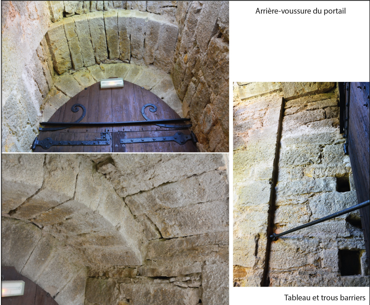
Figure 108 : Château des Allymes. Portail d'entrée, détails de construction. Doc. : E. Chauvin-Desfleurs, L. D'Agostino
