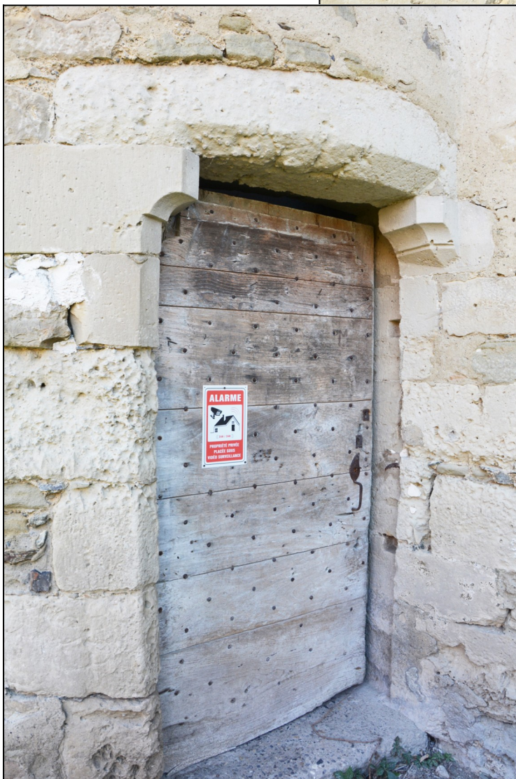
Figure 156 : Mionnaz (74). Tour d'escalier, porte d'entrée. Cliché : E. Chauvin-Desfleurs.
