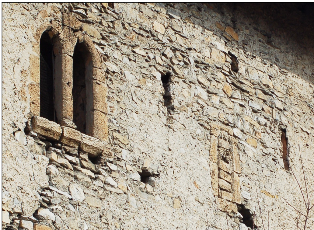
Figure 32 : Maison forte de Dingy (Passy, Haute-Savoie), baie géminée et jour à coussinets. Cliché : L. D'Agostino.
