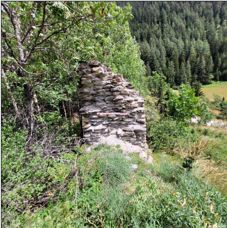
Figure 87 : Rocher des Sarrazins : coupe du mur d'enceinte nord, l'espace interne se situe à droite (Cliché D. Billoin).
