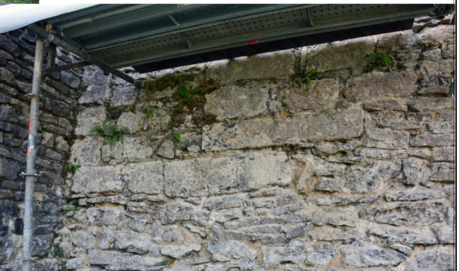
Ragréages au ciment gris sous le seuil.
