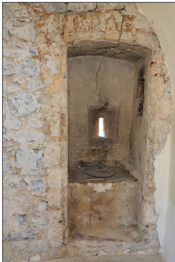
Figure 30 : Château de Vachères (Montclar-sur-Gervanne, Drôme), latrines de la tour d'artillerie nord. Cliché : L. D'Agostino.
