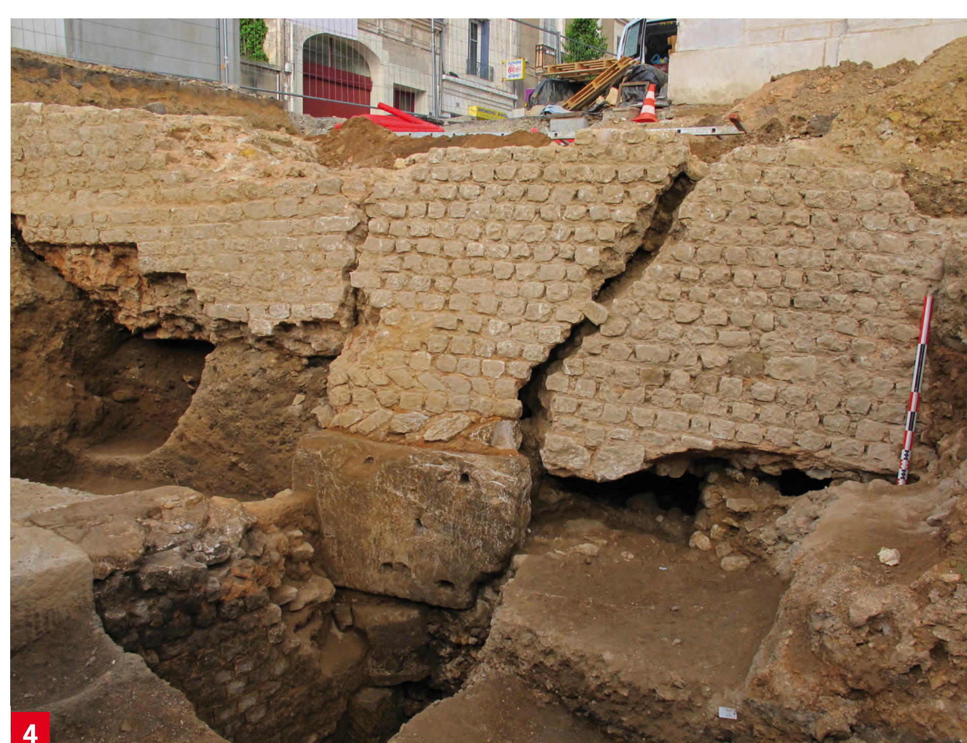
4. Le rempart du Bas-Empire Ses puissantes fondations ont servi de carrière au Moyen Âge. Les espaces ainsi évidés ont été transformés en caves. © Frédéric Gerber, Inrap
