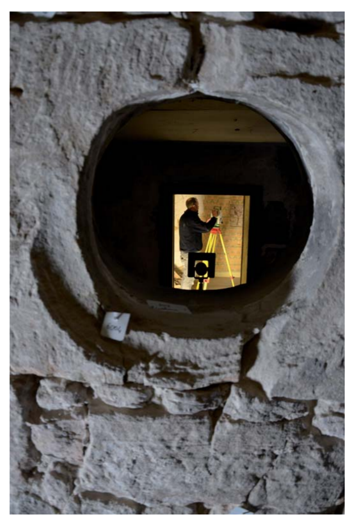
4 Levé topographique en cours, au premier étage oculus conservé, chevet, premier étage
