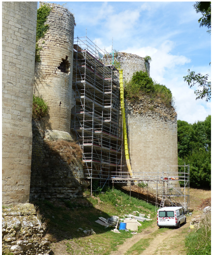
Fig. 12 - Echafaudage de la courtine 45, vue vers le nord. (A. Montigny, Inrap)
