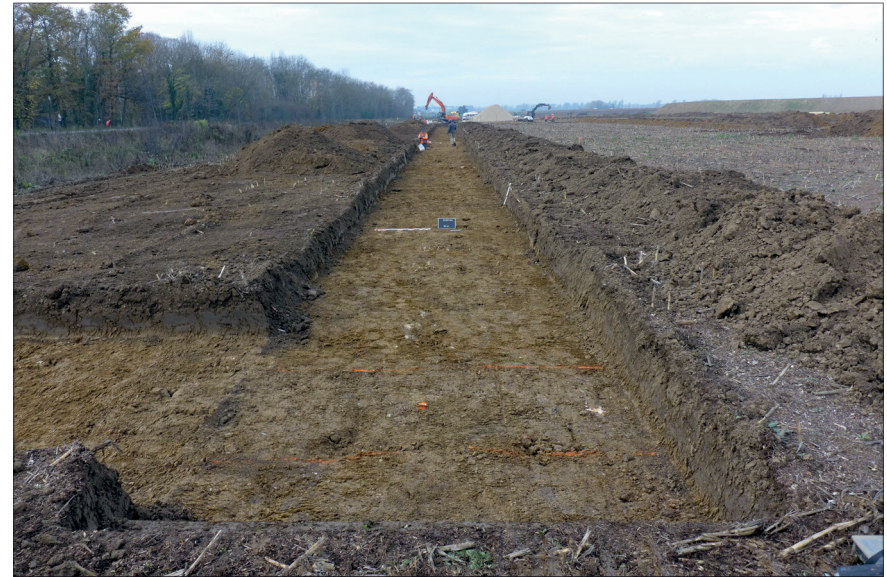
B : Vue générale de la TR12 depuis l'ESE, le 27/11/2020.
