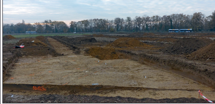
Vue générale de la TR11 depuis le Nord, le 27/11/2020 (cliché n°107 : © INRAP, V. Da-Veiga-Semedo)
