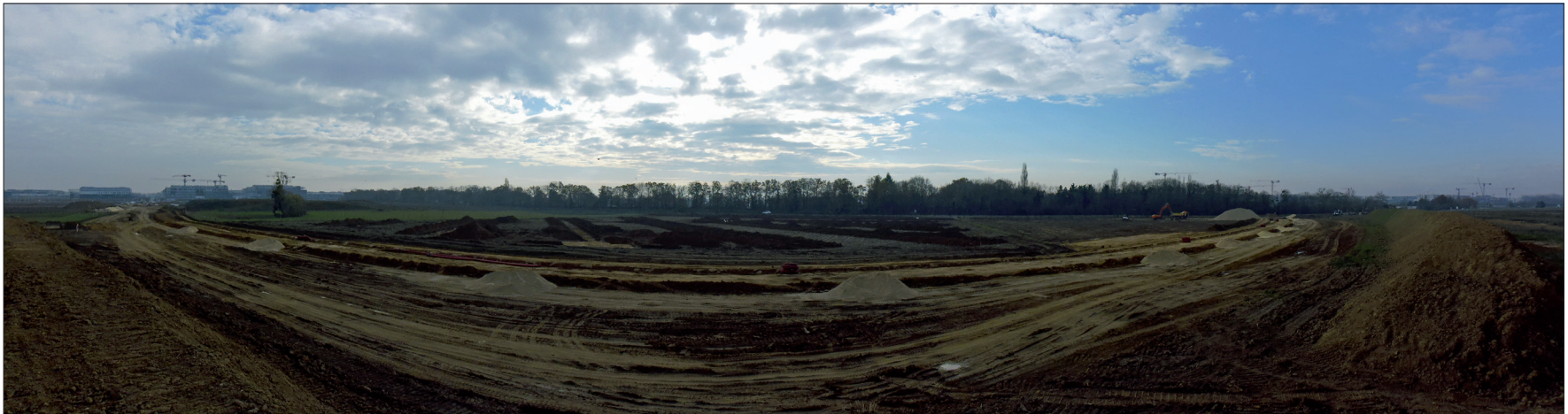
B : Vue panoramique de la Zone Sud, depuis le Nord, le 27/11/2020 ; au premier plan, travaux de la ligne du métro 18 (cliché n° 125 ; © INRAP : G. Desrayaud)
