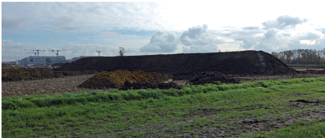
Fig. 08 Orsay (91), Zac de Corbeville, partie Ouest, phase 2, merlon de terre dans l'angle SO de la Zone Nord, vue depuis le NO, le 20/11/2020 (cliché n°031) © INRAP : G. Desrayaud
