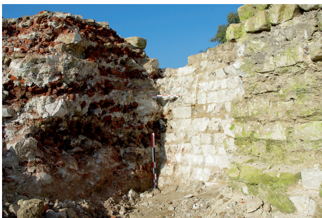
Fig. 7 - Vue vers le nord du sondage réalisé dans le contrefort d'angle et la face du bastion à la pelle hydraulique. (E. Delmont, Inrap, 2016)
