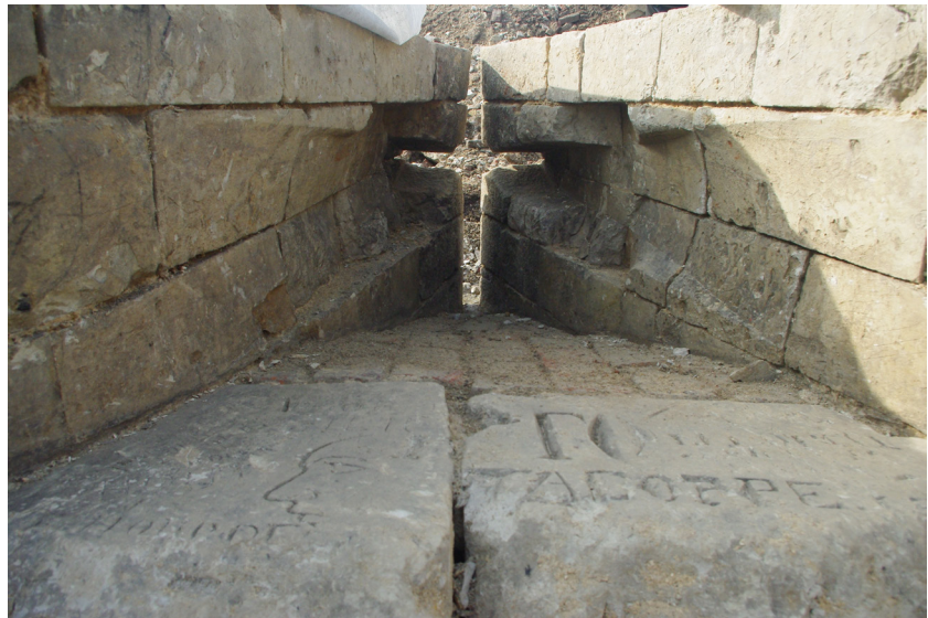
Fig. 15 - L'archère 1266 vers l'extérieur de la tour 1047. (V. Decoupigny, Inrap, 2014)
