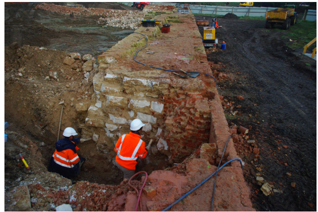
Fig. 8 - Vue vers le nord-ouest du sondage réalisé dans la face du bastion à la pelle hydraulique. (E. Delmont, Inrap, 2016)
