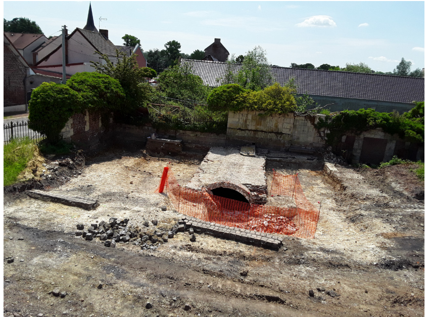
Fig. 18 - Vue générale de la citerne 2002 et d'une partie de la clôture du jardin du château. (J. Georges, Inrap, 2021)
